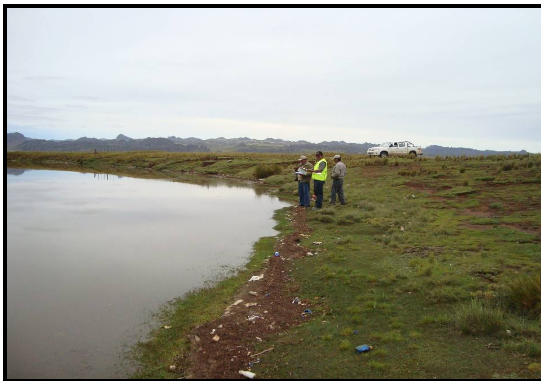
Fotografía N° 27: Punto de Verificación de coordenadas en Sector Canchagolgan (360,541 E, 8'793,230 N), ubicado al norte del dique de la Represa Upamayo, el incremento del nivel de agua de la presa a cubierto los sectores con posible contaminación con sedimentos que afectan a los pastizales y pobladores de la zona.
