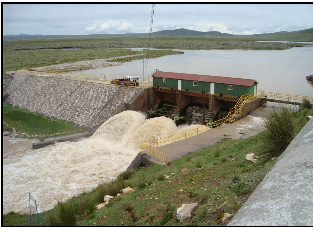
Fotografía N° 10: Dique de la Represa Upamayo, obsérvese la descarga de agua por el sistema de compuertas y aliviadero de demasías.
