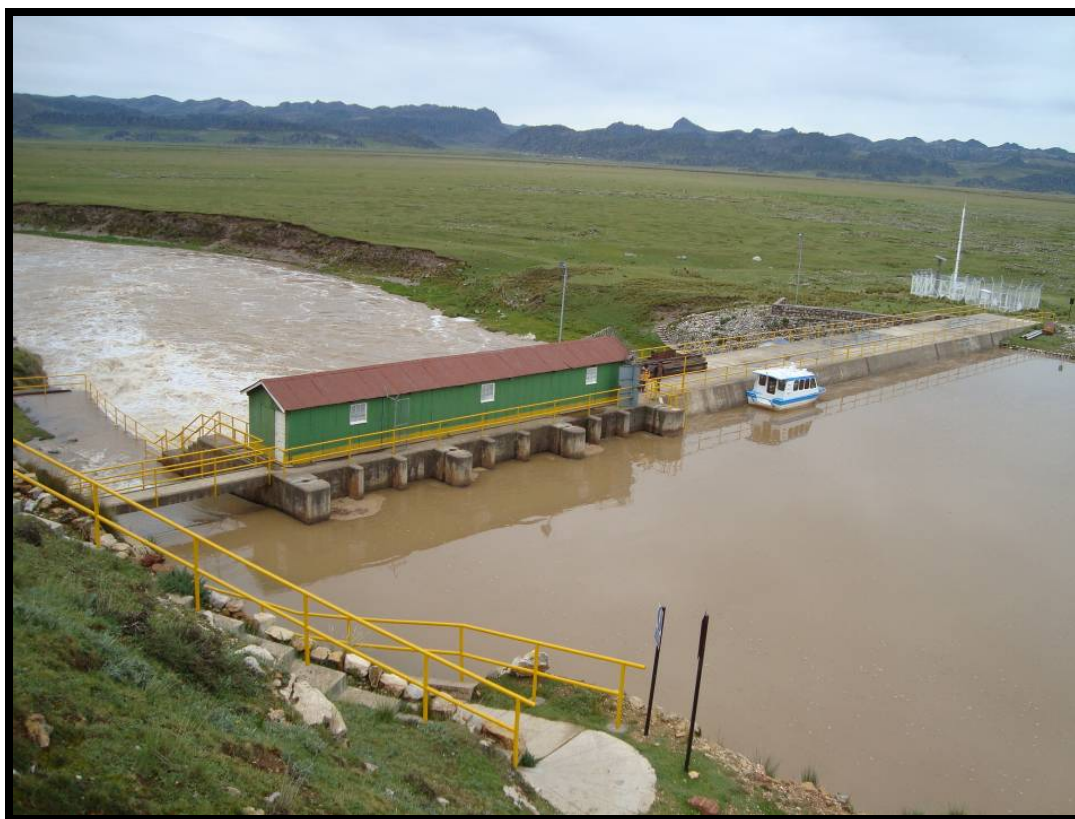
Fotografía N° 4: Dique de la Represa Upamayo, obsérvese el rebose por el aliviadero de demasías, al haber alcanzado la represa su nivel máximo.
