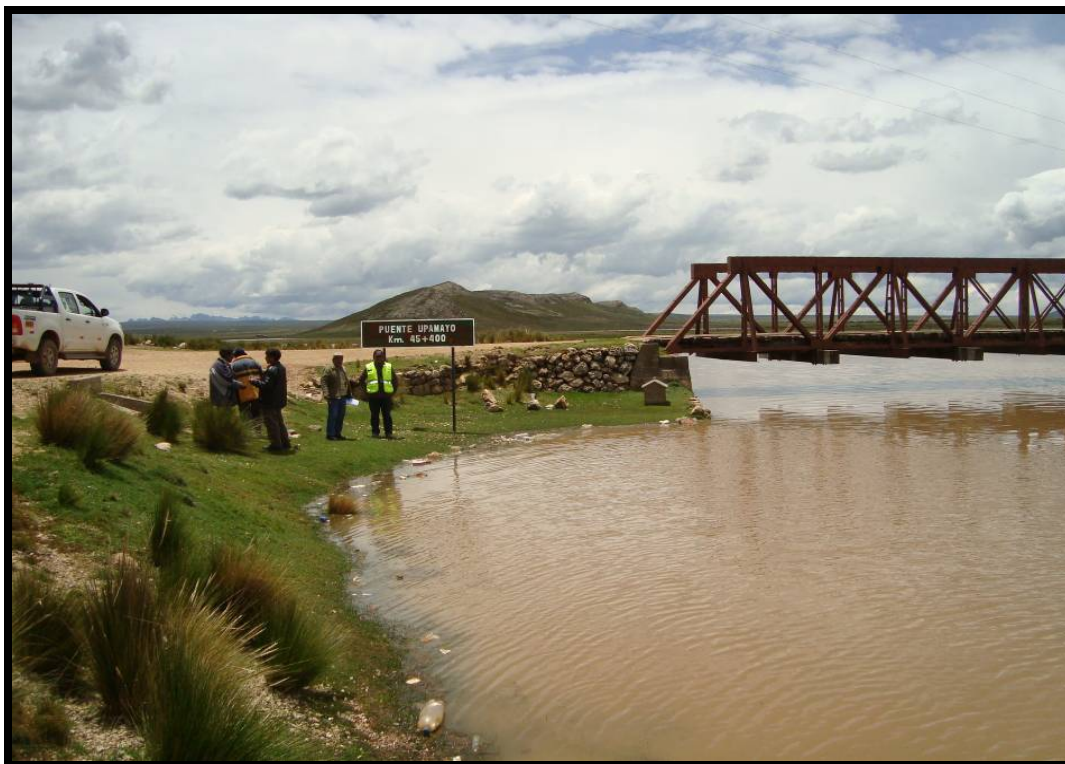
Fotografía N° 15: Punto de Verificación de coordenadas en Sector Puente Upamayo (361,987 N, 8'792,436 N), se observa el lago Chinchaycocha en nivel máximo de almacenamiento de agua y el agua cargada de sedimentos.
