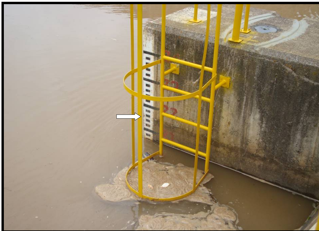
Fotografía N° 5: Nivel de la cota de embalse del agua en la Represa Upamayo se ubica en los 21,700 pies.
