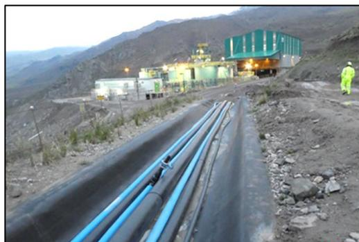
**Compañía de Minas Buenaventura S.A.A. Concesión de Beneficio "Tambomayo".** Tubería matriz HDPE de 6" de Ø del bombeo de relaves hacia los tanques de alimentación de filtrado; canal de contingencia impermeabilizado con geomembrana HDPE.
