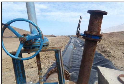
**Minera Shouxin Perú S.A., Concesión de beneficio "Planta Concentradora Polimetálica MSP".** Tramo final que tiene un recorrido de 1000 m (tubería tipo HTIDC de 400 mm de Ø); con válvulas de venteo en los puntos más altos y válvulas de drenaje en los puntos más bajos.
