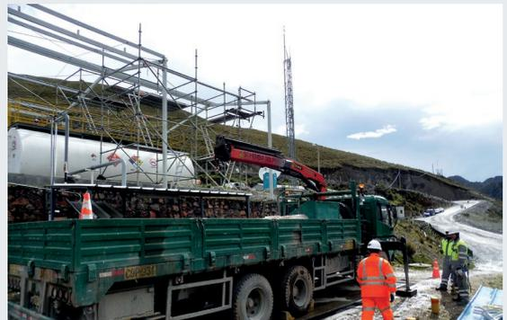
Grúa móvil de 5360 kg de capacidad máxima de izaje, dotada de un dispositivo de sonido que alarma respecto a su desplazamiento o giro, estacionada frente al área de almacenamiento de combustible.
