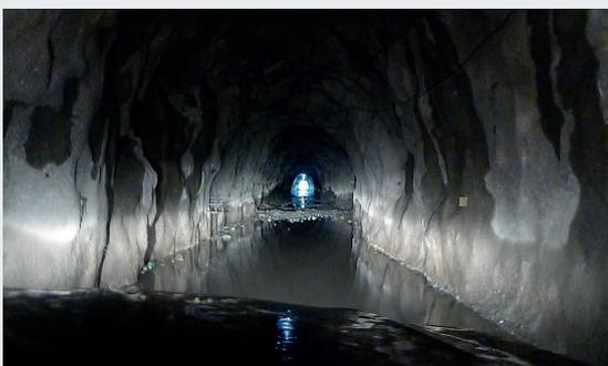
Galería anegada con acumulación de agua y deterioro del piso.
