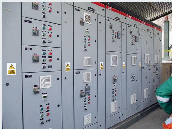
Tableros de control de motores eléctricos de equipos aislados y con puertas de acceso controlado con chapas de seguridad a cargo de un electricista, ubicados en el centro de control de motores del área de chancado.
