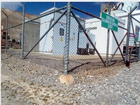
Subestación eléctrica de columnas de carbón CA 22,900 V, con cerco perimétrico de mallas metálicas y con puesta a tierra.
