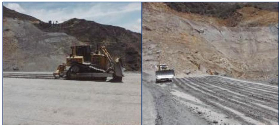
De acuerdo con esto se propone cargar el depósito en capas de 0.30 y 0.35 m de altura en forma secuencial hasta cubrir todo el depósito, siendo el control realizado en cada capa, empleando el método de densidad de campo con el cono y la arena; cada metro se procederá a verificar las propiedades de la mezcla mediante el ensayo de Proctor Modificado y clasificación.
