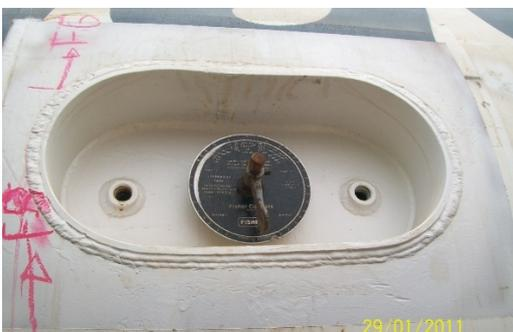
Orificio mayor a N° 54, que requiere la instalación de una válvula de exceso de flujo
