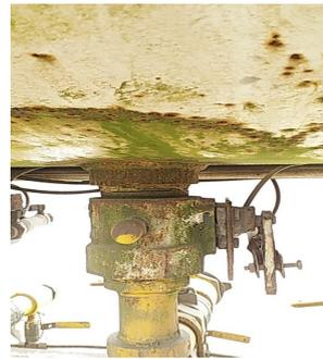
Áreas corroídas en la base del tanque
