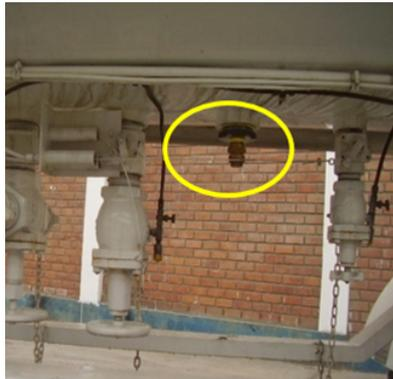
Válvula de exceso de flujo para retiro de líquido
