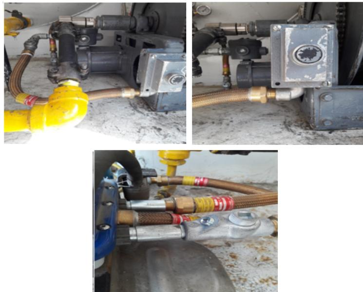
Cajas de paso, conductores y sellos eléctricos adecuados para el tipo de área peligrosa.
