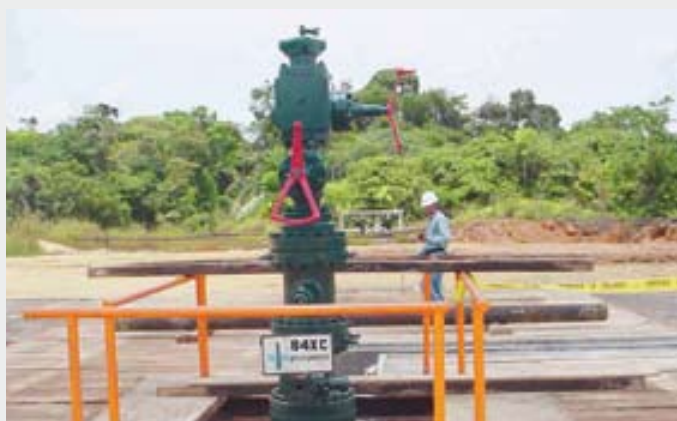
Pozo N° 84 XC, obsérvese cabezal del futuro pozo inyector en buen estado de conservación.
