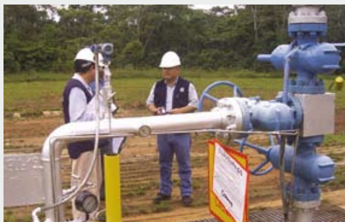
Cierre del pozo F 14 Lote 1 AB.
