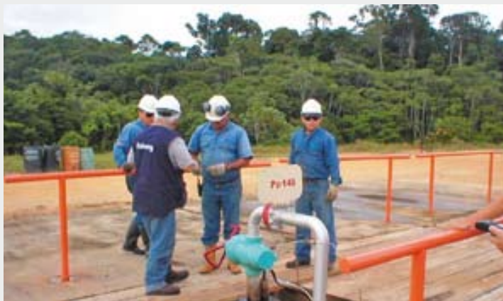
Cierre del pozo 148 Lote 8.
