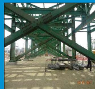
Rack de tuberías de las unidades de FCK y PAR (Aire Comprimido).
