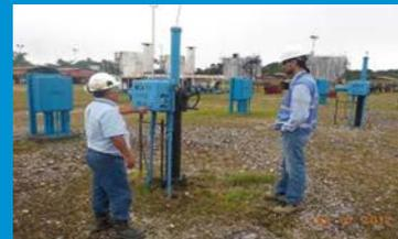
Válvulas de apertura crudo del ORN al TK-5D-03 (Estac. 5)
