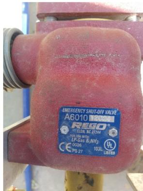
En la fotografía adjunta se verifica que la imagen corresponde a una válvula de cierre de emergencia. Por tanto, la elección del accesorio válvula de cierre positivo es incorrecta.
