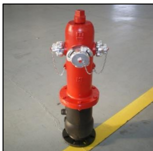
Gráfico 1. Hidrante tipo pedestal
