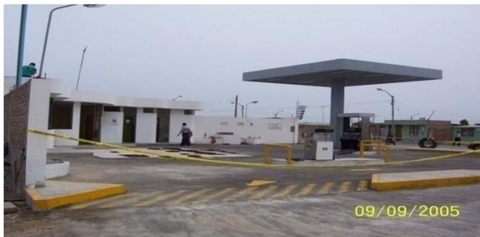
Ángulos en la entrada y salida entre 30° y 45° medidas tomadas dentro de la proyección del límite de propiedad a la calzada
