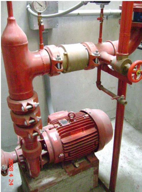
Las bombas deberán estar alimentadas independientemente del interruptor general de la instalación, con un generador eléctrico que permita su operación en caso de corte o suspensión de energía eléctrica
