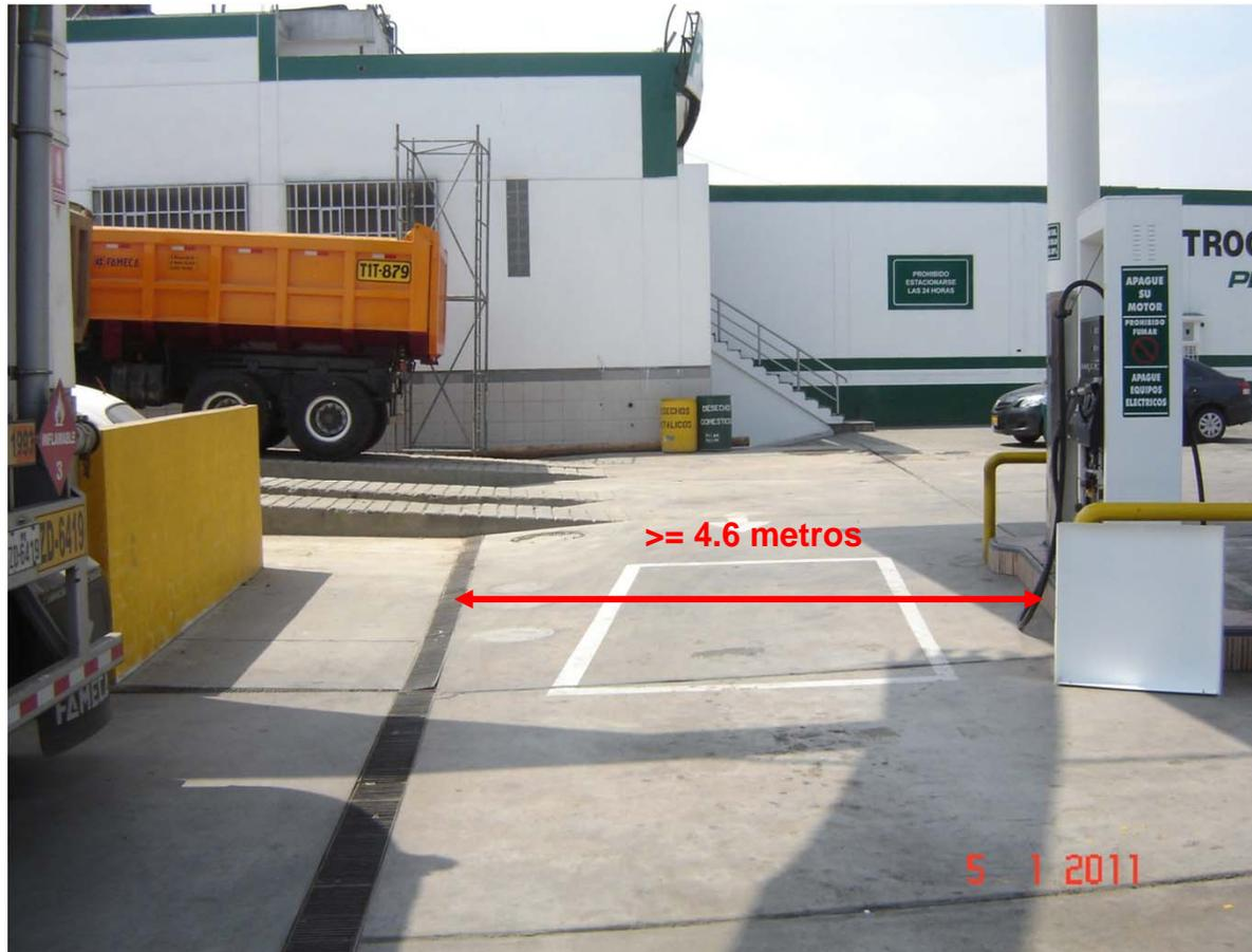
Los equipos de despacho deben encontrarse alejados de fosas con drenajes o descargas de fluidos dirigidos hacia la abertura de un sistema cloacal o dentro de los 15 pies (4,6 metros)
