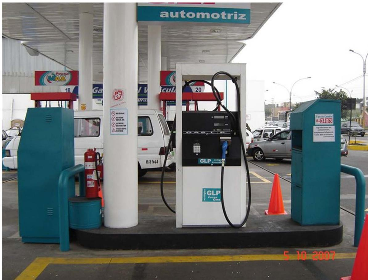
Las mangueras que se usen para el despacho de GLP deben encontrarse protegidas contra presiones hidrostáticas excesivas mediante válvulas de alivio de seguridad
