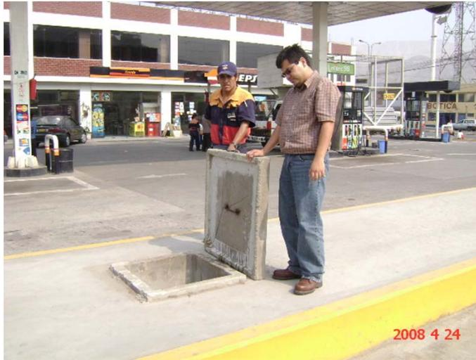
**Sistema de almacenamiento de agua, bombas contraincendio y mangueras, para mantener un flujo de doscientos cincuenta galones por minuto (250 gpm) (946,3 lpm) por dos (2) horas**
