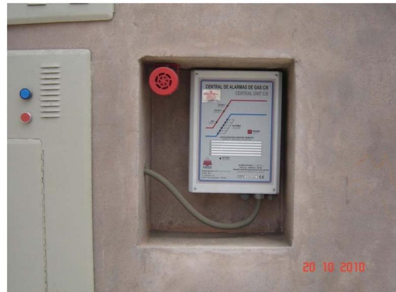
**El establecimiento debe contar con un sistema de alarma con detectores continuos de presencia de gases en la atmósfera, diseñado de acuerdo a la norma NFPA 72.**
