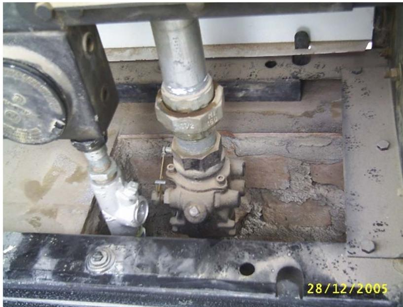
**CUMPLIMIENTO: VISTA DE LAS VÁLVULAS DE CIERRE AUTOMÁTICO SOPORTADAS A TRAVÉS DE BARRA METÁLICA**
