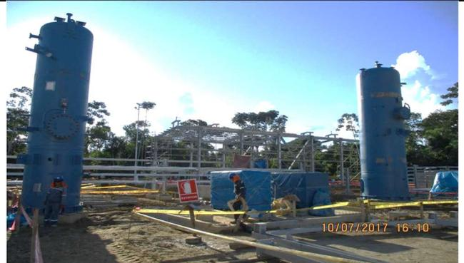
**Repsol - Planta Compresora Nuevo Mundo U-400: Vista de los tanques de almacenamiento de aire para el sistema de instrumentación.**
