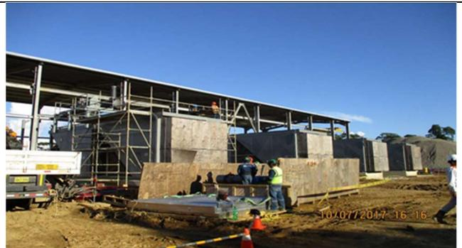
**Repsol - Planta Compresora Nuevo Mundo U-400: Vista de la instalación de los motocompresores.**
