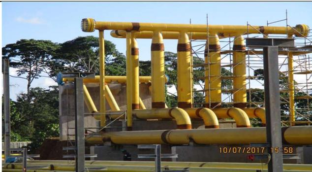
**Repsol - Planta Compresora Nuevo Mundo U-400: Vista del manifold de recolección de gas obtenido del slug catcher, para ser comprimidos en los motocompresores.**
