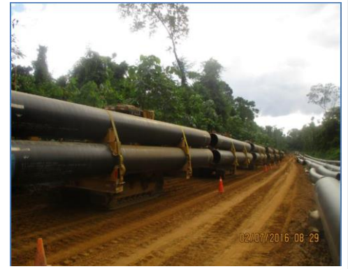
Tramo B - Segmento 1, KP-0010+000 Transporte de tubería de 32", a través De seis pipe carriers, al KP 22+100.
