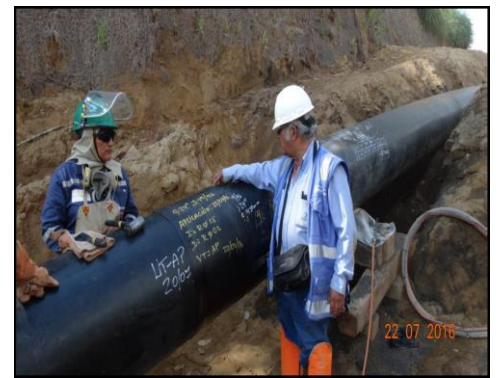
Tramo B – Segmento 1, KP 19+550 Supervisión de manta termocontraíble colocada en la junta de soldadura del ducto de 24" Ø.
