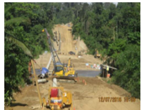
Tramo B – Segmento 1, KP 14+420 Actividades de soldadura en el tramo que cruzará el río Capanashiri.
