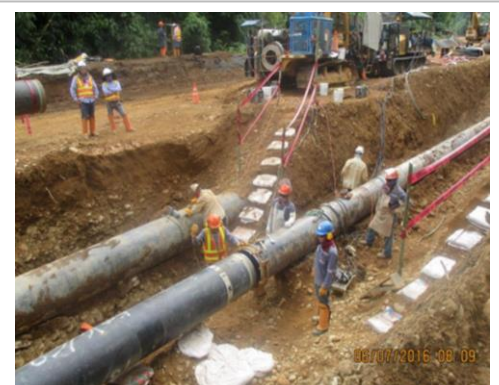
Tramo B - Segmento 1, KP16+847 Vista de los ductos de 32" Ø (GN) y 24" Ø (LGN). Se puede apreciar el alineamiento de la junta J16/69 (tie-in) en la tubería de GN.
