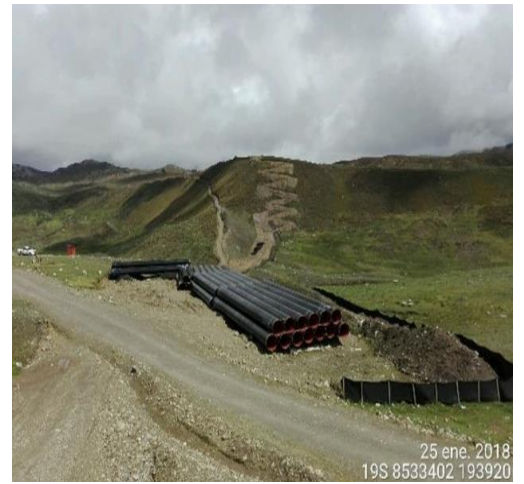
KP 296+400 – KP 296+700: Verificación de los trabajos de preservación y mantenimiento
