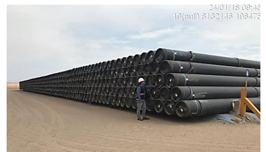
La Joya – Verificación del estado de tuberías de 32" de diámetro
