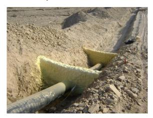
Fig. 3 Tapón en espuma (poliuretano) DDV PERULNG
