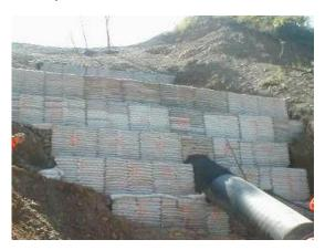
Fig. 4 Tapón en gavión (SSC + Canastilla de gavión)
