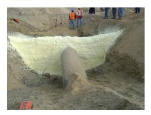
Fig. 11: Barrea en zanja instalada, nótese que el cable de fibra óptica al igual que el ducto esta empotrada en el elemento de retención.
