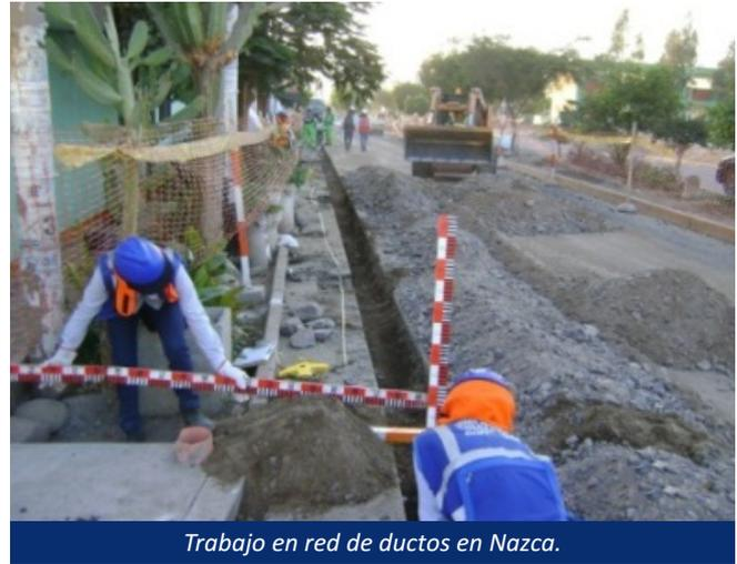
Avance de construcción de tubería de polietileno instalado por ciudad
