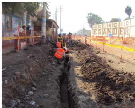
Trabajos de Tendido de Tubería de PE en Av. Abraham Valdelomar
