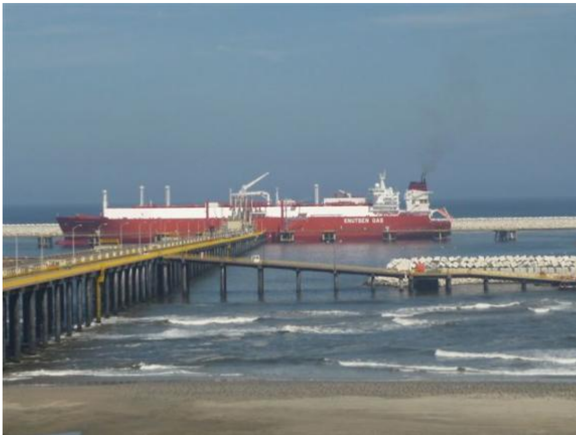
Buque Metanero “Barcelona Knutsen” acoderado al lado del Jetty de la Planta
