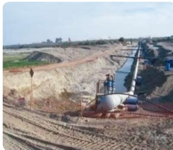
Pruebas de presión al ducto en el cruce del río Pisco
