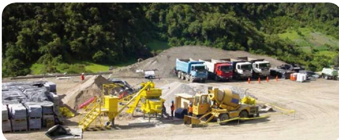
Preparación de agregados para cimentación de futura Planta Compresora
