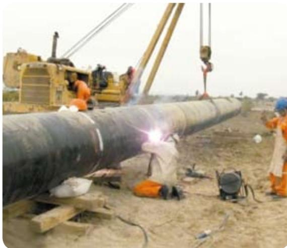
Soldadura de la tubería en tramos especiales
