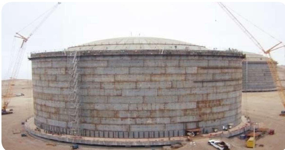
Izamiento del techo del tanque N° 3402
