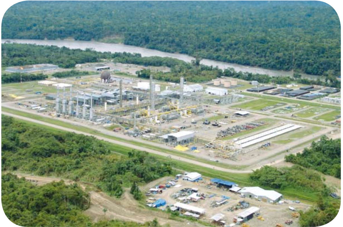
Planta de Separación de Malvinas
