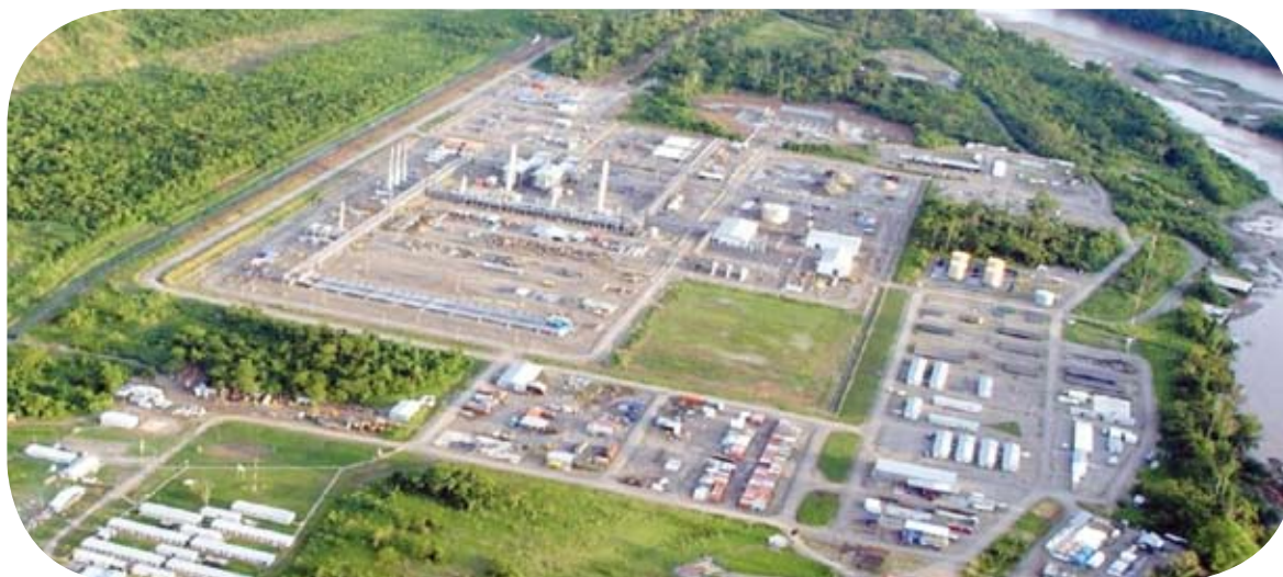
Planta de Separación de Gas Natural de Malvinas
