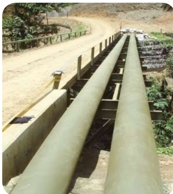
Líneas de 18" y 20" entre la Planta de Malvinas y Pozo Pagoreni A
