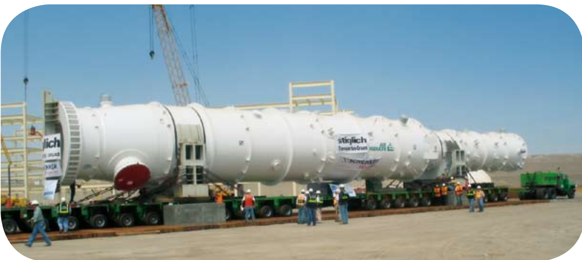
Intercambiador Principal E-1405
