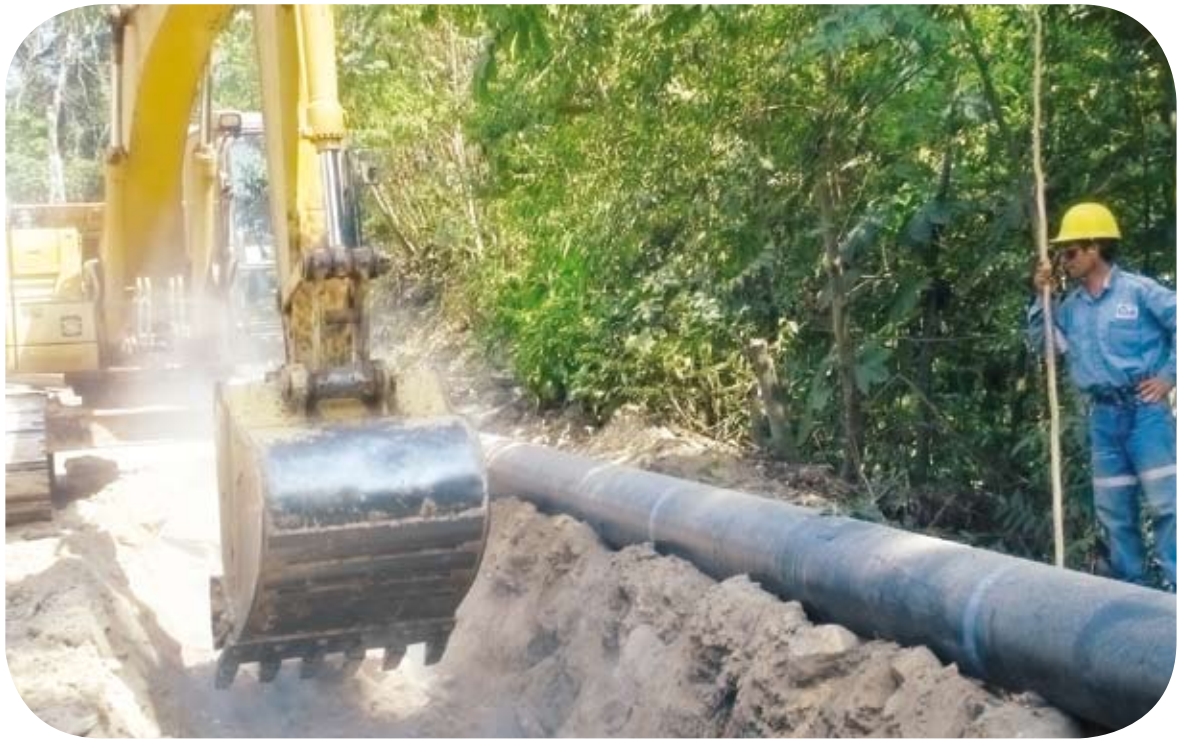
Construcción de ducto de 18" entre Pozos Pagoreni A y Pagoreni B
