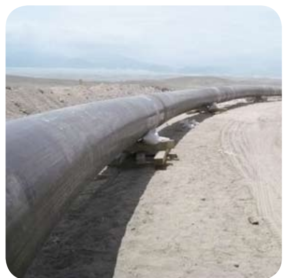
Primer tramo construido del ducto principal de Perú LNG en la zona de la costa
