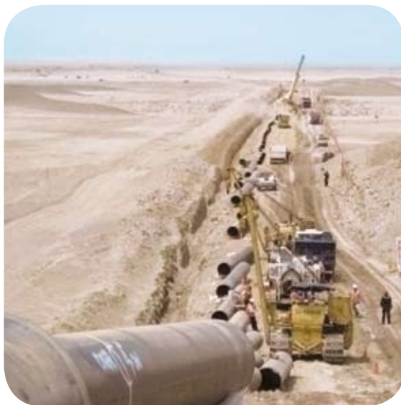
Desfile de tuberías antes del inicio del proceso de soldadura
