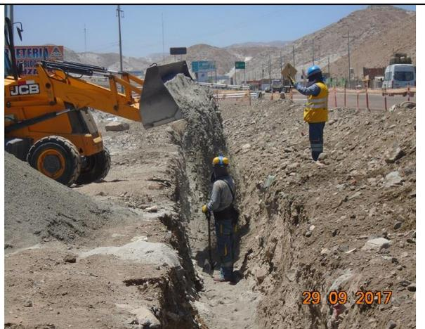
**Foto 10.- Redes La Joya:** Se verifica la instalación de la cama de arena fina en fondo de zanja.
