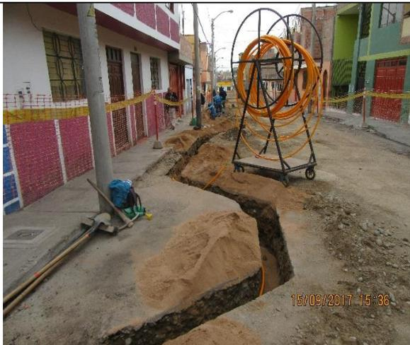
**Foto 07.- Redes Tacna:** Se verifica instalación la tubería de polietileno dentro de la zanja.
