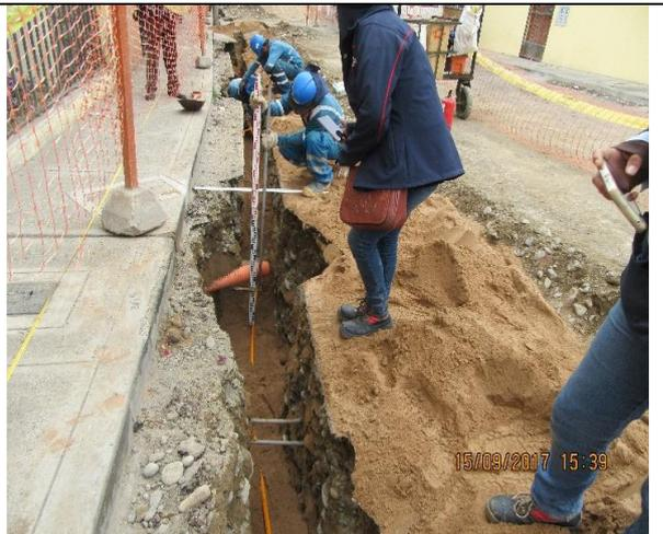
**Foto 08.- Redes Tacna:** Se verifica la tapada de tubería y la verificación de las distancias a interferencias.
