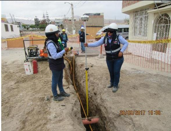
**Foto 11.- Redes Ilo:** Determinando posición de los puntos singulares utilizando la unidad portátil de GPS.
