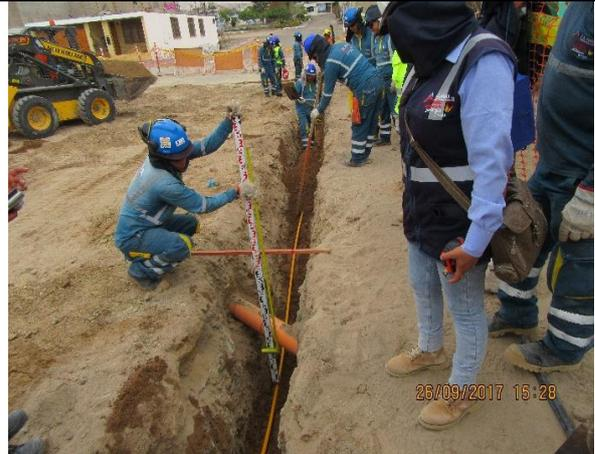
**Foto 12.- Redes Ilo:** Verificando la distancia hasta las interferencias y la tapada de tubería.
