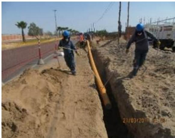
**Foto 17.- Redes en Tacna:** verificación de la instalación de tubería de PE de  $\varnothing 200$  mm.
