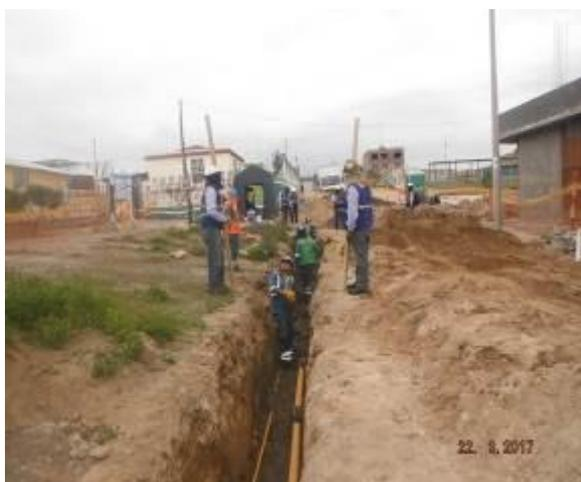
**Foto 15.- Redes Arequipa:** verificación de instalación de dos tuberías de PE de Ø90mm.
