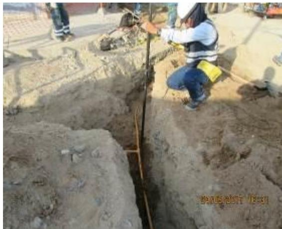
**Foto 18.- Redes en Tacna:** verificación del registro de ubicación de tubería utilizando equipo GPS.
