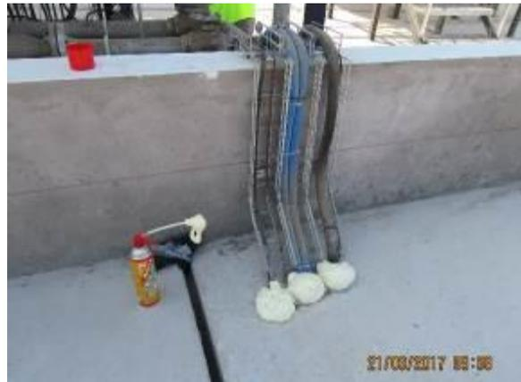
**Foto 14.- Estación de Distrito de Ilo:** verificando el sellado de cables del sistema eléctrico e instrumentación.
