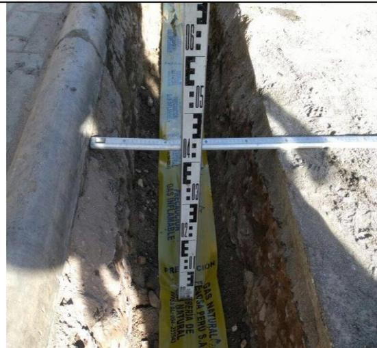
**Foto 10.- Redes Arequipa:** verificación de instalación de cinta de señalización en el proceso de tapada de tubería.
