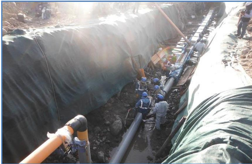
Foto 5.- Redes Arequipa: Se verifica el proceso de Instalación de tubería Ø200mm y casing de protección de Ø 18", en cruce especial de Río Socabaya.
