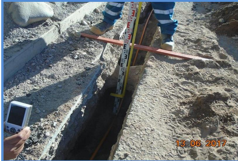
Foto 7.- Instalación de Redes en Moquegua: Verificando de la distancia a interferencias en la instalación de tubería de PE Ø25mm.
