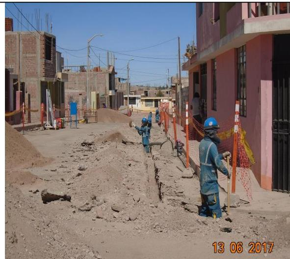
**Foto 12- Instalación de Redes en Moquegua:** Verificación de la excavación de zanjas en forma manual en el CP de San Antonio-Moquegua.
