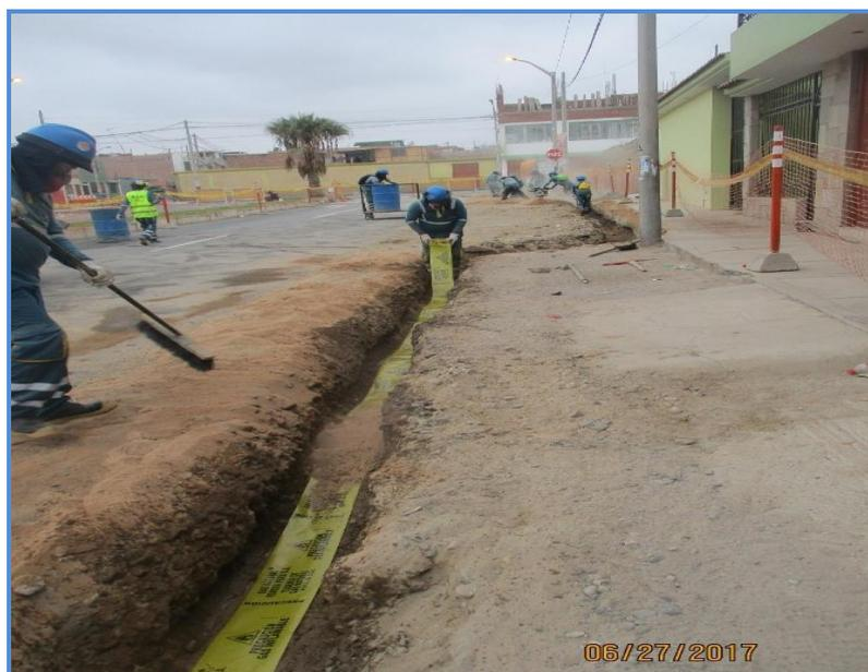
Foto 8.- Instalación de Redes en Tacna: verificación de la instalación de cinta de seguridad sobre tubería de PE de Ø25 mm.
