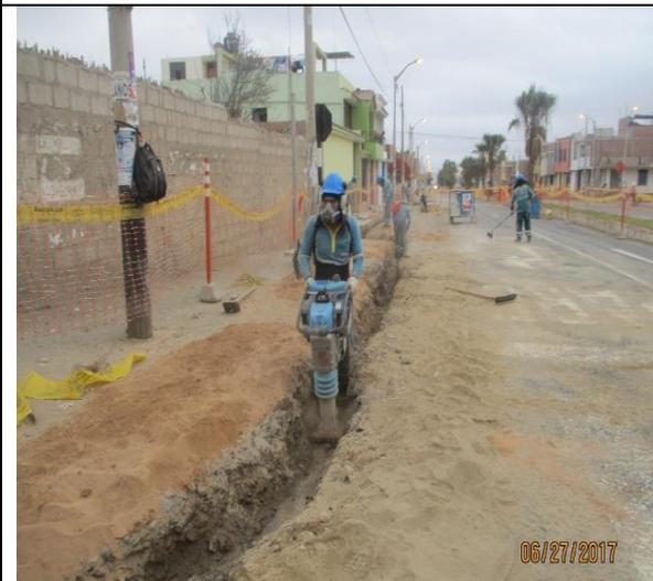
**Foto 11.- Redes Tacna:** verificando la compactación en zanja en el Distrito de Tacna.
