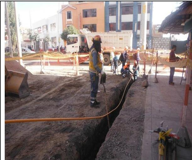
**Foto 9.- Redes Arequipa:** se verifica instalación de tubería de Ø25 mm en el Distrito de Jose Luis Bustamante y Rivero.
