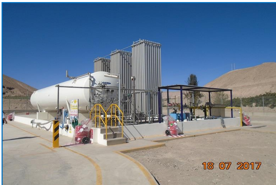
Foto 03.- Vista de la Estación de Distrito MOQUEGUA
