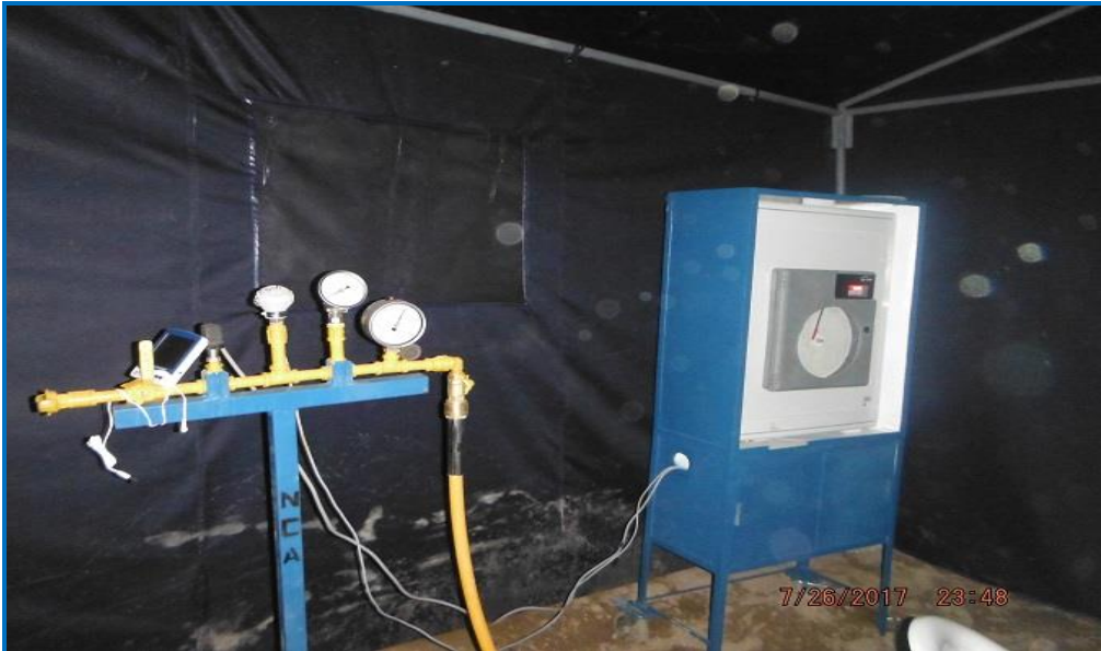
Foto 06.- Redes Arequipa: Verificación de pruebas de hermeticidad en redes de distribución usando manotermógrafo.
