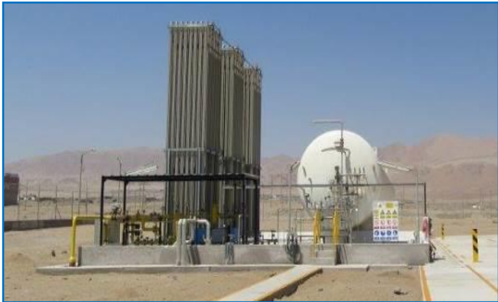
Foto 05.- Vista de la Estación de Distrito ILO
