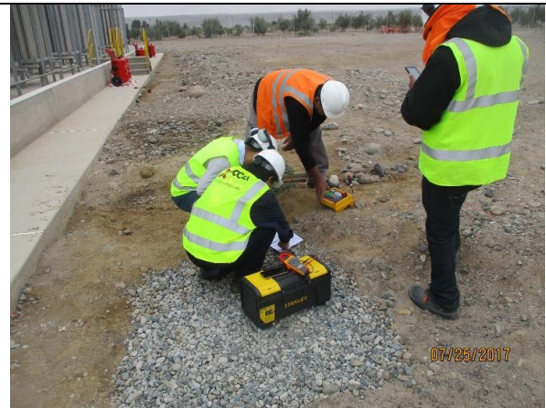
Foto 13.- Redes Tacna: Se verifica la medición del sistema de puesta a tierra con equipo telurómetro.
