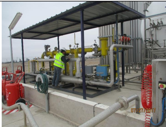
Foto 12.- Estación de Distritos Tacna: Se verifica identificación de instrumentos de ERM.
