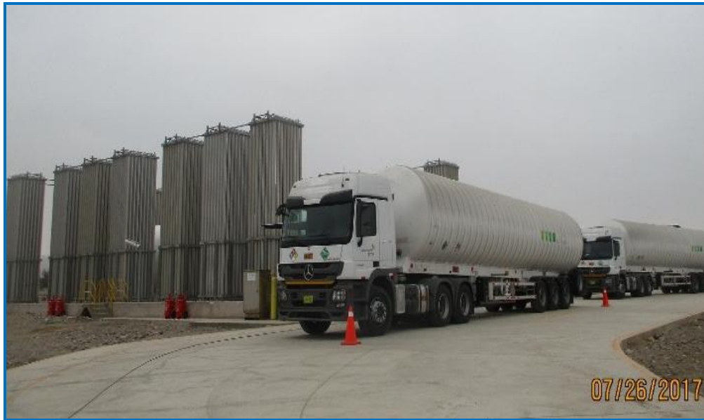
Foto 04.- Estación de Distrito de Tacna: Cisternas con Nitrógeno líquido para las pruebas de Puesta en frío de tanques de GNL
