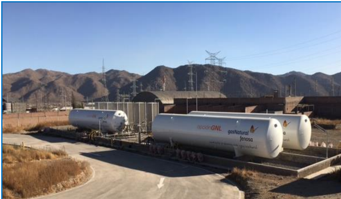
Foto 02.- Vista de la Estación de Distrito AREQUIPA SUR
