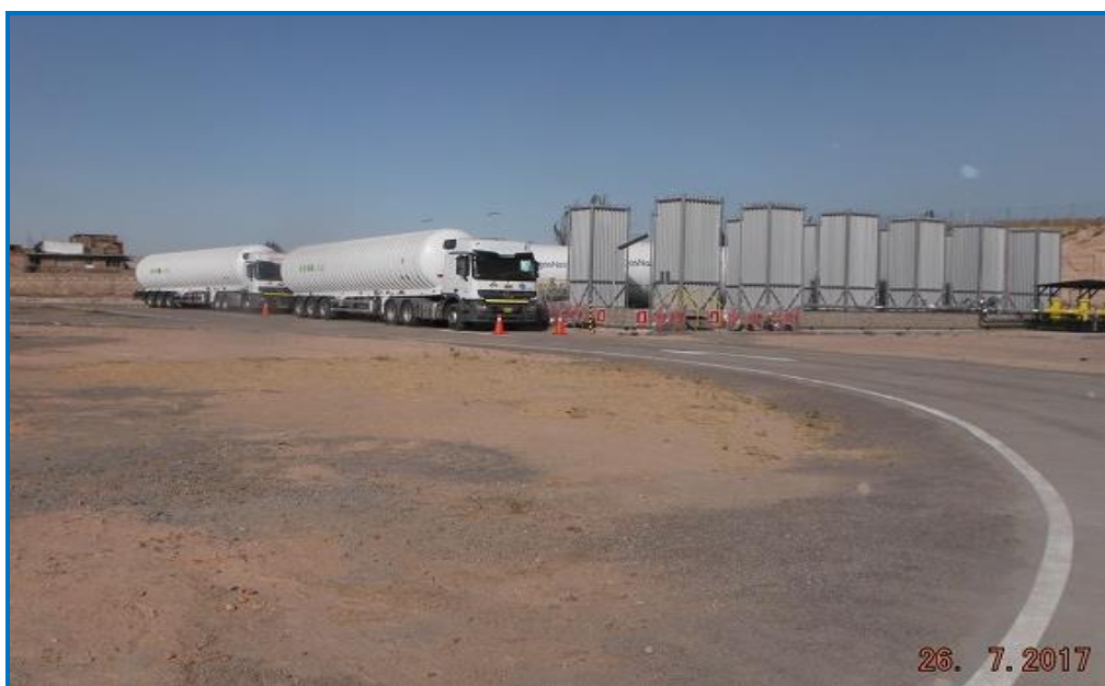
Foto 01.- Estación de Distrito de Arequipa Norte: Cisternas con Nitrógeno líquido para las pruebas de Puesta en frío de tanques de GNL
