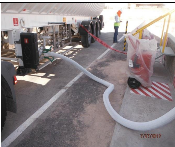
Foto 14.- Estación de Distrito Arequipa: verificando el trasvase de nitrógeno líquido de camión cisterna a tanque.
