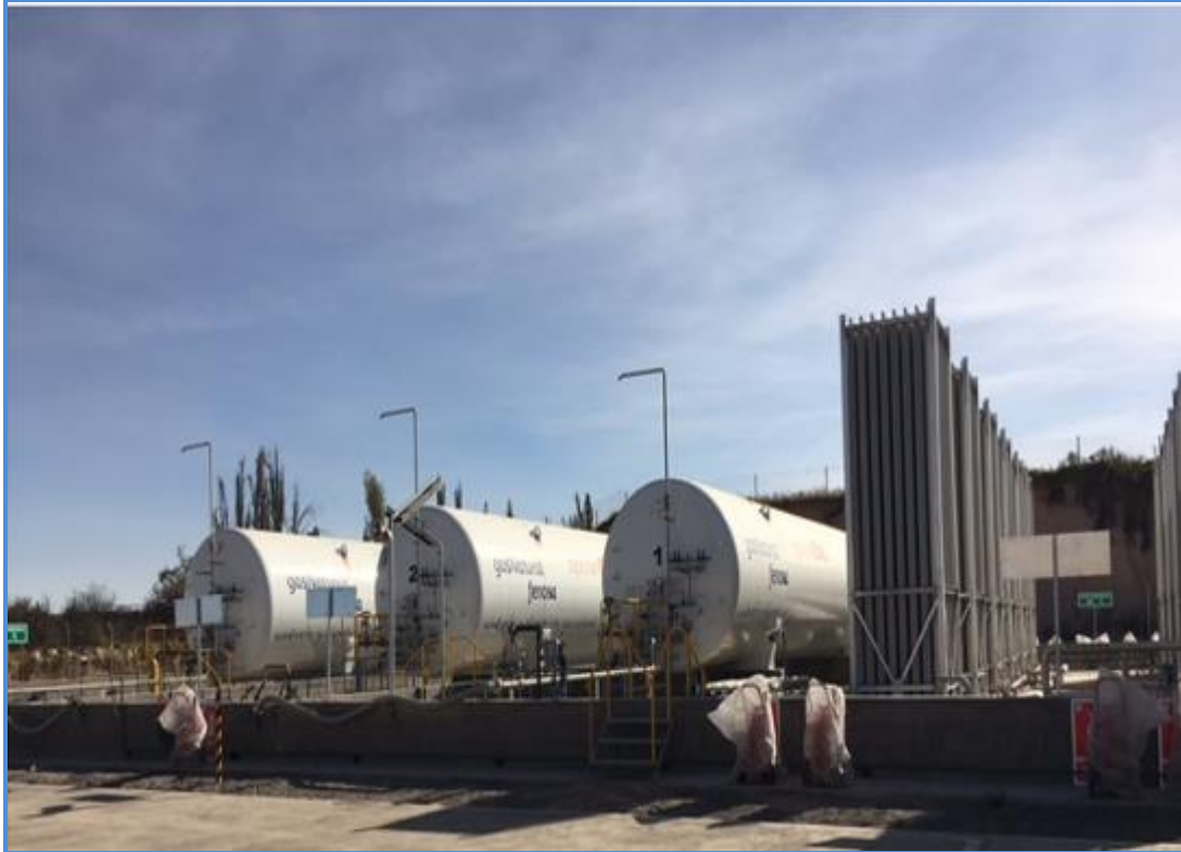
Foto 01.- Vista de la Estación de Distrito AREQUIPA NORTE
