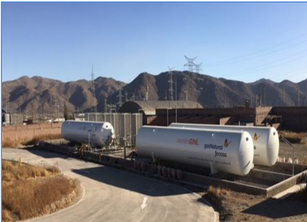
Foto 02.- Vista de la Estación de Distrito AREQUIPA SUR
