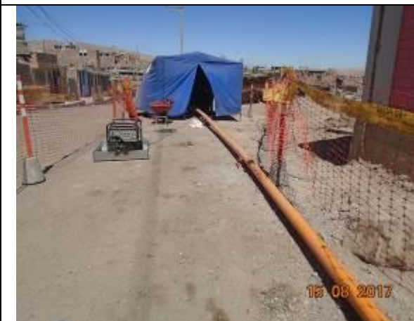
Foto 09.-Redes Moquegua: Se verifica fusión de tubería de PE Ø110 mm en Urb Lopez Albuja.
