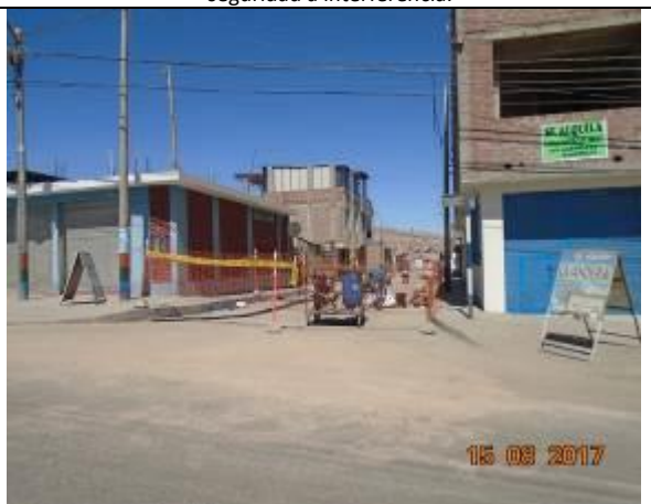
Foto 10.- Redes Moquegua: Se verifica trabajos en Urb. Lopez Albuja-CP San Antonio
