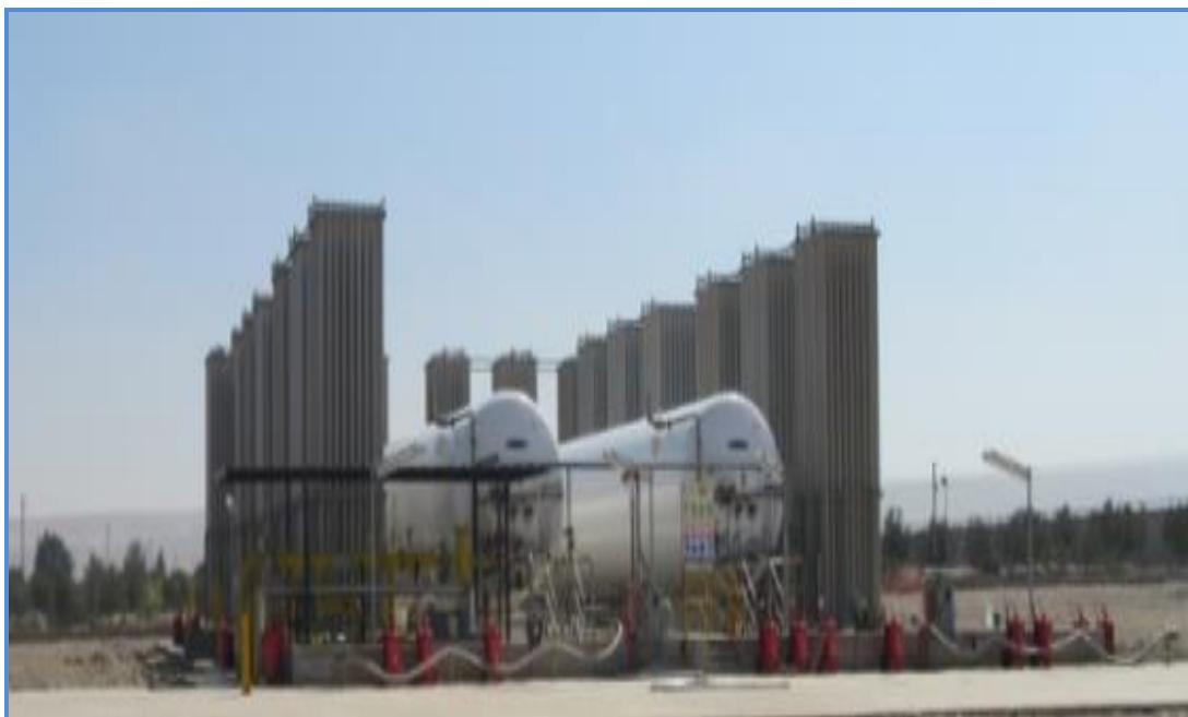
Foto 04.- Vista de la Estación de Distrito TACNA
