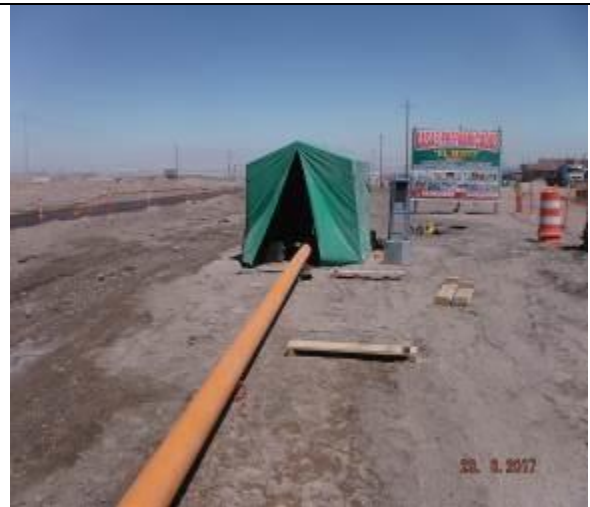
Foto 07.- Redes Arequipa: se verifica fusión de tubería de PE de Ø200 mm en el distrito de La Joya.
