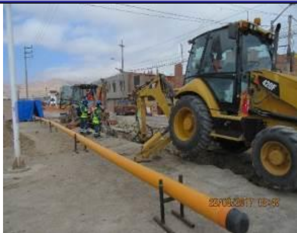
Foto 11.- Redes Ilo: verificando fusión y apertura de zanja para tubería de PE Ø200 mm.
