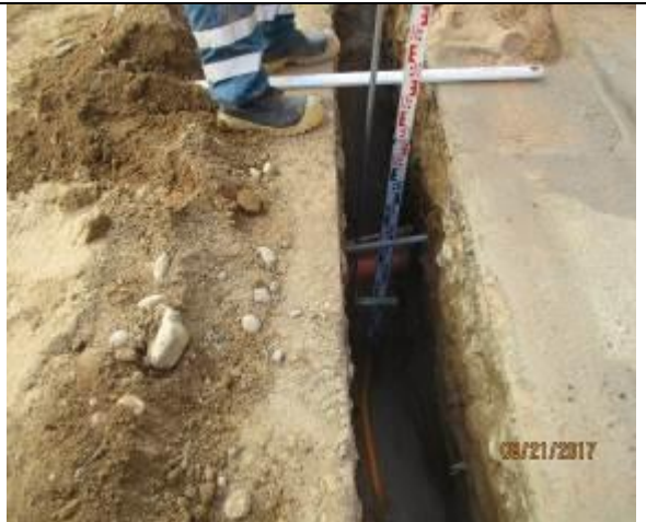
Foto 08.- Redes Tacna: Se verifica altura de tapada y distancia de seguridad a interferencia.
