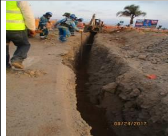
Foto 07.- Redes Tacna: Se verifica tapada en Ovalo Tarapacá
