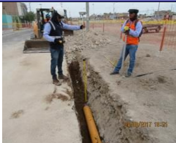
Foto 12.- Redes Ilo: verificando con unidad portátil de GPS la ubicación de tubería de PE.
