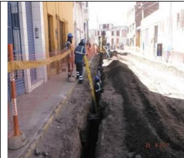
Foto 06.- Redes Arequipa: Se verifica instalación de tubería de PE Ø200 mm en Pampita Zevallos Yanahuara
