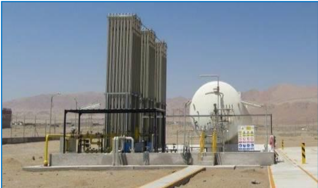
Foto 05.- Vista de la Estación de Distrito ILO
