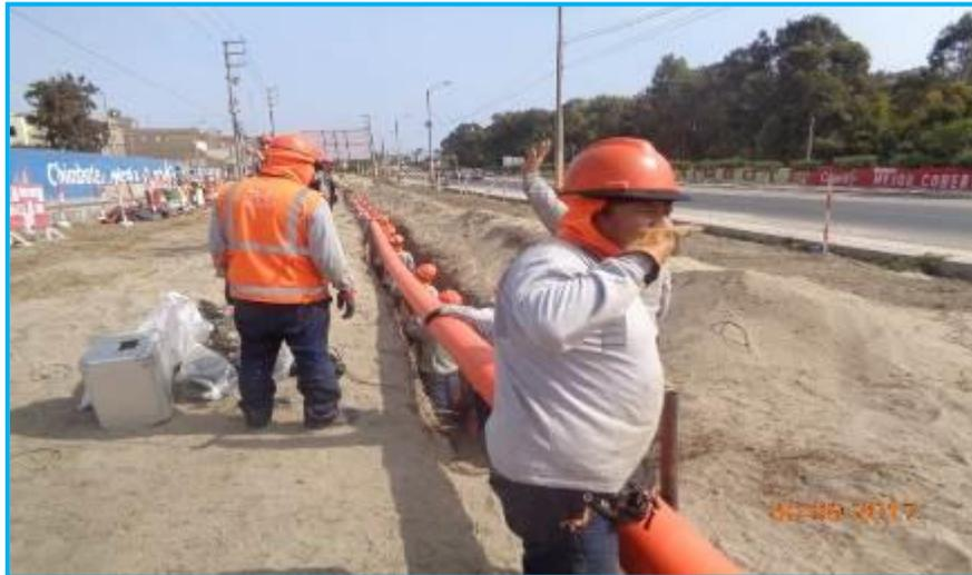
Foto 10.- Traslado de tubería de Ø200mm a zanja, Ref. Av. Panamericana Norte- Chimbote
