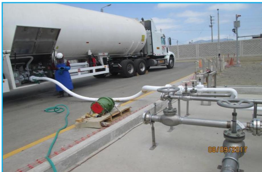
**Foto 05.-** Estación de Distrito de Chimbote, vista de la descarga de Nitrógeno Líquido de Cisterna a Tanque de GNL.
