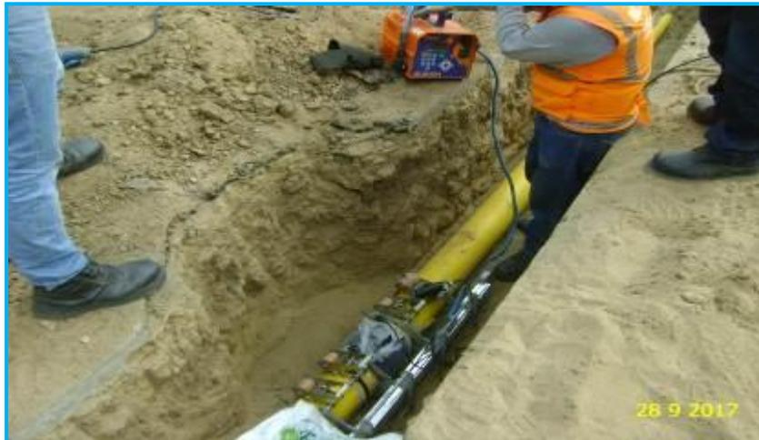
Foto 08.- Redes Trujillo, Unión de tuberías de Ø160 mm, mediante de termofusión tipo socket, en Av. Cesar Vallejo.
