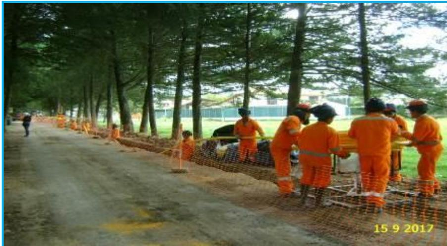
Foto 12.- Redes Cajamarca, Instalación de tuberías de PE de Ø63 mm, en Vía a Hotel la Ensenada.
