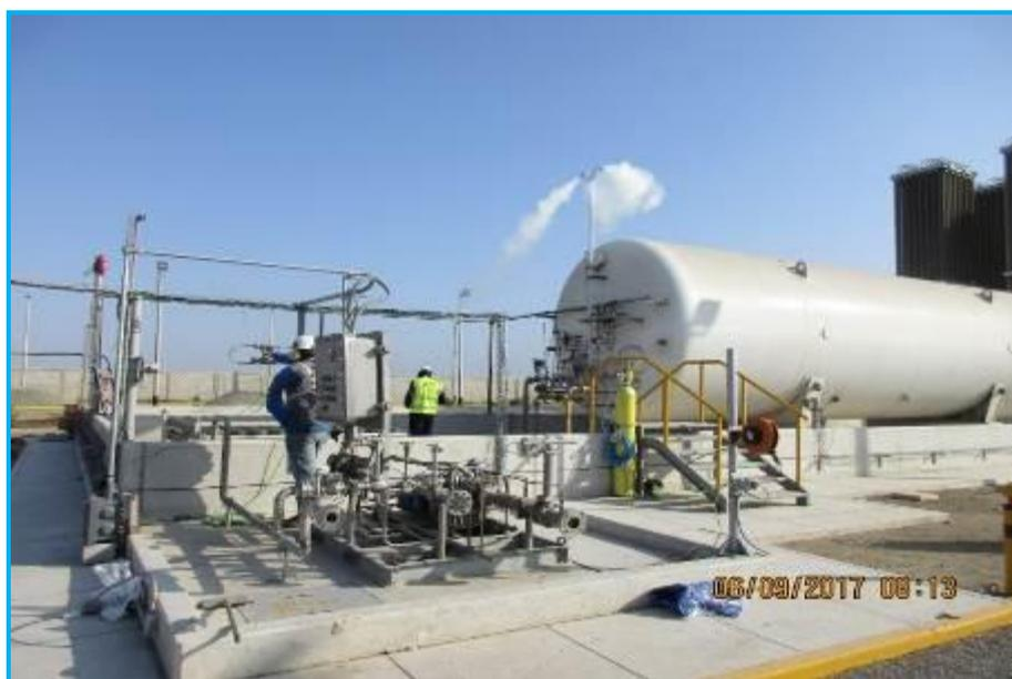
**Foto 04.-** Estación de Distrito de Chiclayo, vista del funcionamiento del venteo e Inertización de tuberías de entrada y salida de vaporizador hasta la ERM.
