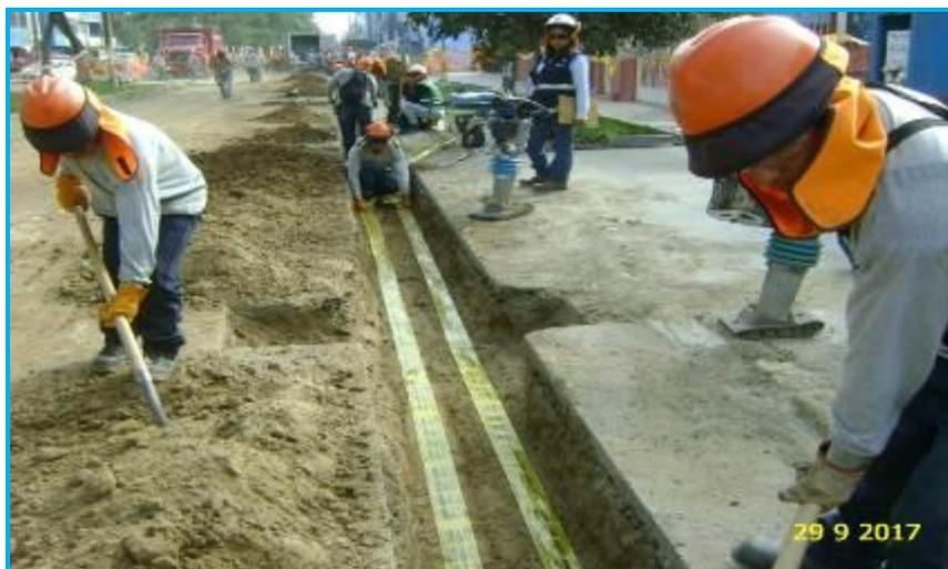
Foto 09.- Redes Trujillo, colocación de cintas de señalización sobre tuberías de Ø160 mm Ø32 mm, en Av. Cesar Vallejo.
