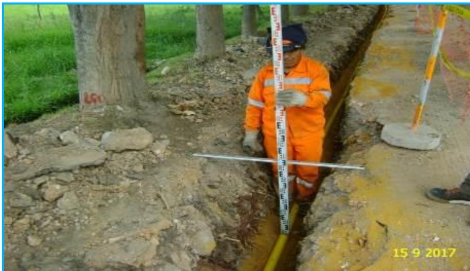
Foto 13.- Redes Cajamarca, vista de profundidad de tubería de Ø63 mm (-0.67 m), en Vía a Hotel la Ensenada.
