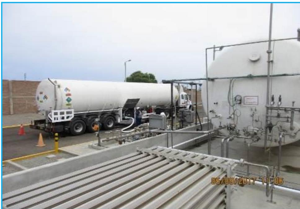
**Foto 01.-** Vista del llenado de tanques con Nitrógeno Líquido en la Estación Distrito de Trujillo.
