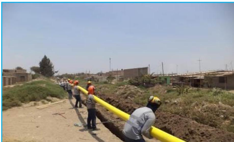
**Foto 14.- Redes Lambayeque,** vista de Instalación de tubería, sin esfuerzos que dañen la tubería, se verifica la supervisión de GDP.
