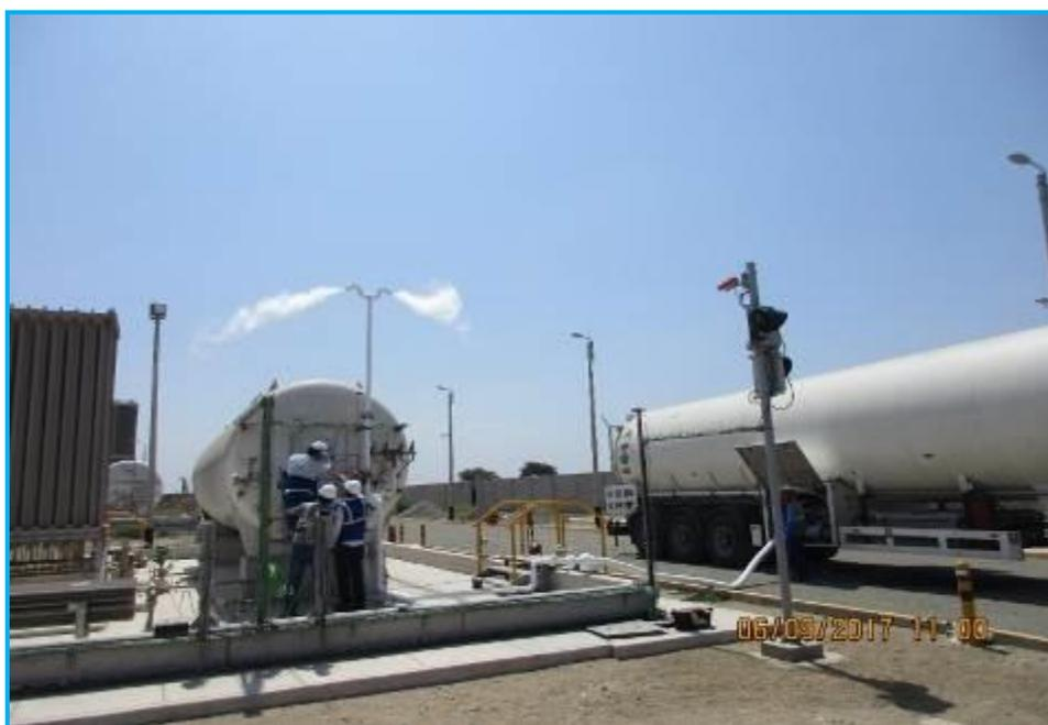
**Foto 03.-** Estación de Distrito de Lambayeque, vista de la inertización, vaporización, venteo y presurización de las líneas, los vaporizadores y ERM.
