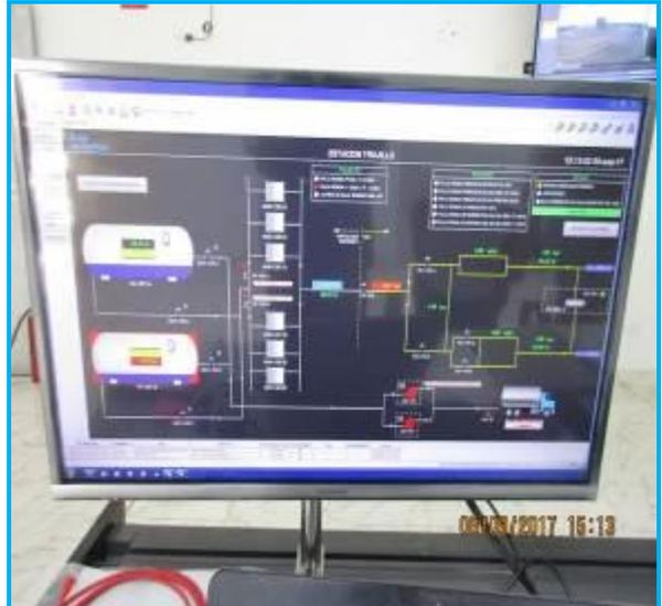
**Foto 17.- E.D. Trujillo,** vista del control (pruebas de llenado con Nitrógeno Líquido de ambos Tanques en el sistema SCADA.
