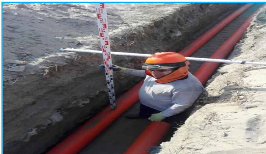
Foto 11.- Redes Chimbote, verificación de la altura de tapada de zanja. Ref. Av. Panamericana Norte.
