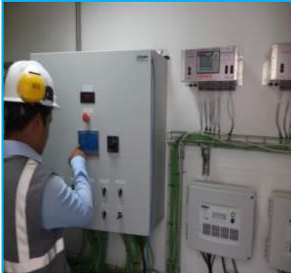
**Foto 16.- E.D. Chiclayo,** Personal de GDP realizando la verificación del sistema de detección de fuego y gas.
