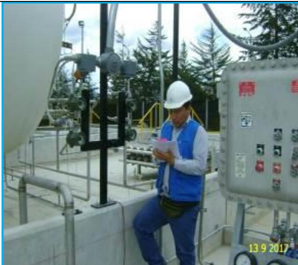
**Foto 18.- E.D. Cajamarca,** verificación de valores de la prueba de lazo in situ en coordinación con sala de control.
