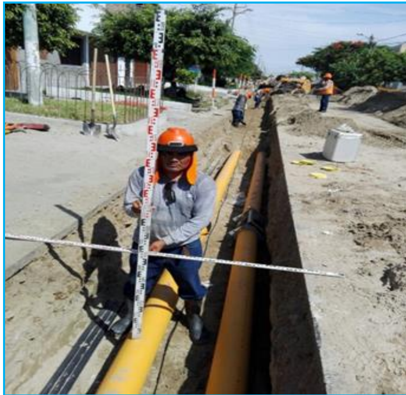
Foto 17.- Vista de la verificación de distancias mínimas, proyecto: PE-16-015 en Urb. El Trapecio Tercera Etapa.
