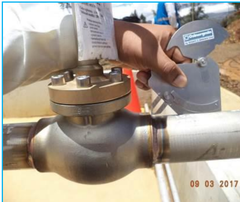
Foto 19.- Vista de la inspección visual de acabados en cordones de soldadura a filete.
