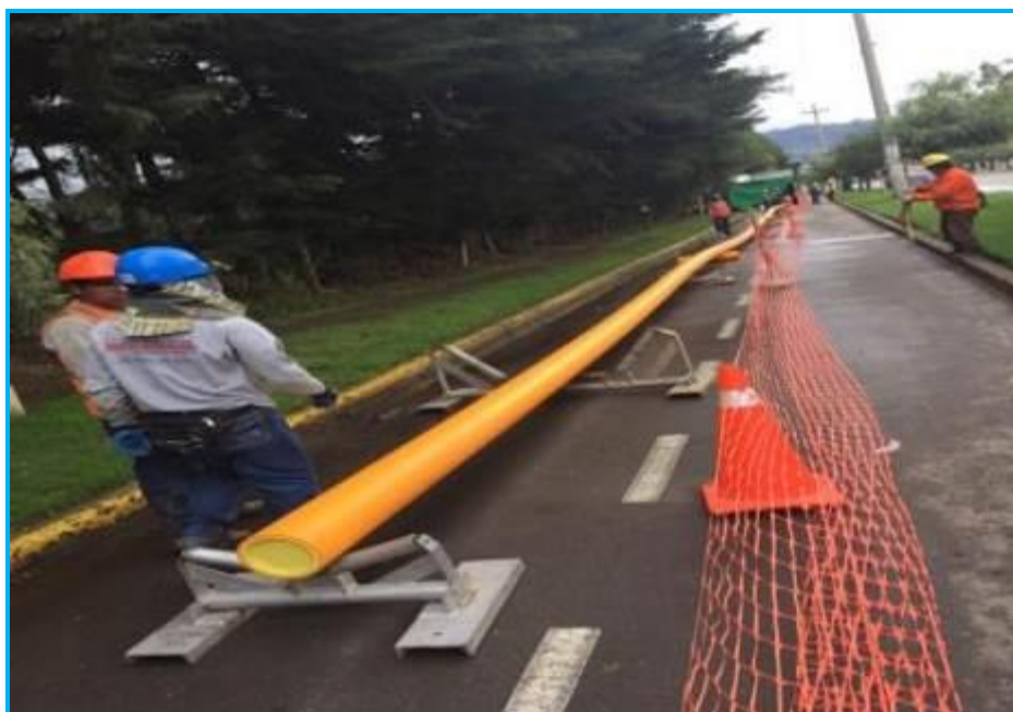
Foto12.- Vista de tubería de PE de Ø200mm antes de ser pasado por la conductora instalada en cruce de Río Mashcon. Longitud de 116 metros.
