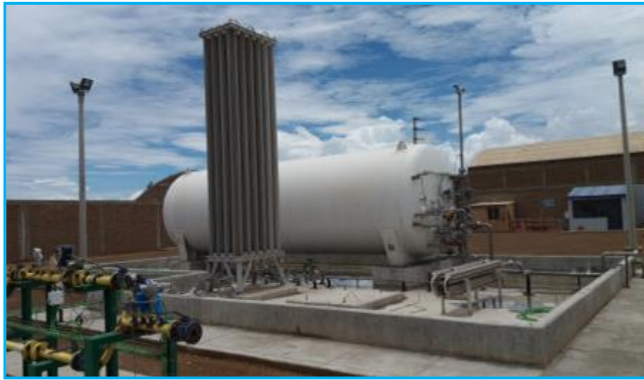
Foto 1.- Vista de la Estación de Distrito Pacasmayo.
