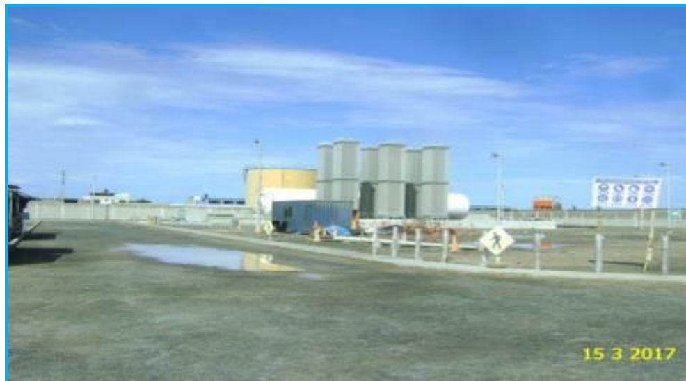
Foto 15.- Vista de zona de acceso vehicular, se observa presencia de agua por precipitaciones de lluvia.
