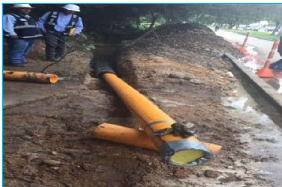
Foto13.- Vista de tubería de Ø200mm introducida en la conductora.
