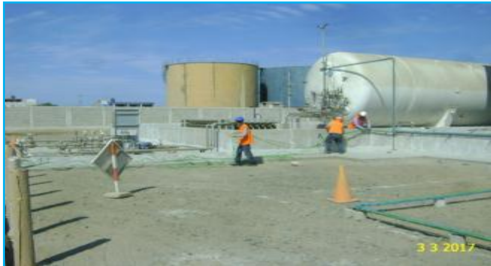
Foto 14.- Vista de la instalación de cable eléctrico para instrumentación en área de procesos.
