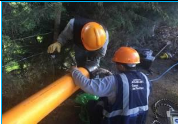
Foto 17.- Redes Cajamarca, Instalación de poliválvulas en extremos de tubería de PE Ø200mm, cruce especial del Río Mashcon, distrito de Baños del Inca, prov. de Cajamarca.
