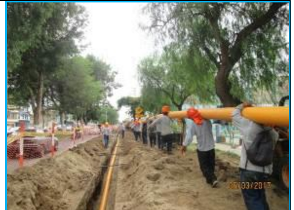
Foto 20.- Redes Trujillo, vista del traslado de varillón Ø200mm, en Av. Túpac Amaru.
