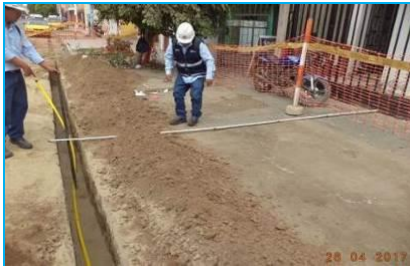
Foto 08.- Redes Trujillo , vista de la instalación de tubería de PE Ø32 mm, en Avenida Guzmán Barrón, se verificaron distancias de seguridad a interferencias, a edificaciones y profundidad de tapada.
