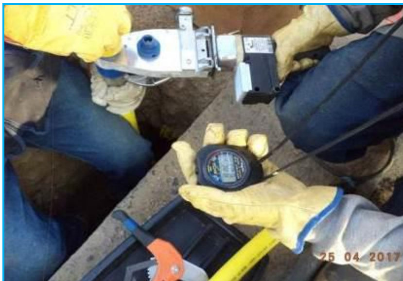
Foto 09.- Redes Trujillo , junta a socket por termofusión, inspección de la aplicación de los parámetros de temperatura y tiempo de acuerdo a sus procedimientos.
