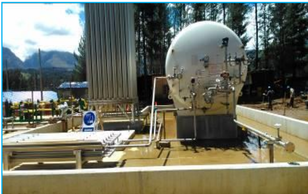
Foto 06.- Vista de Estación de Distrito de Huaraz.
