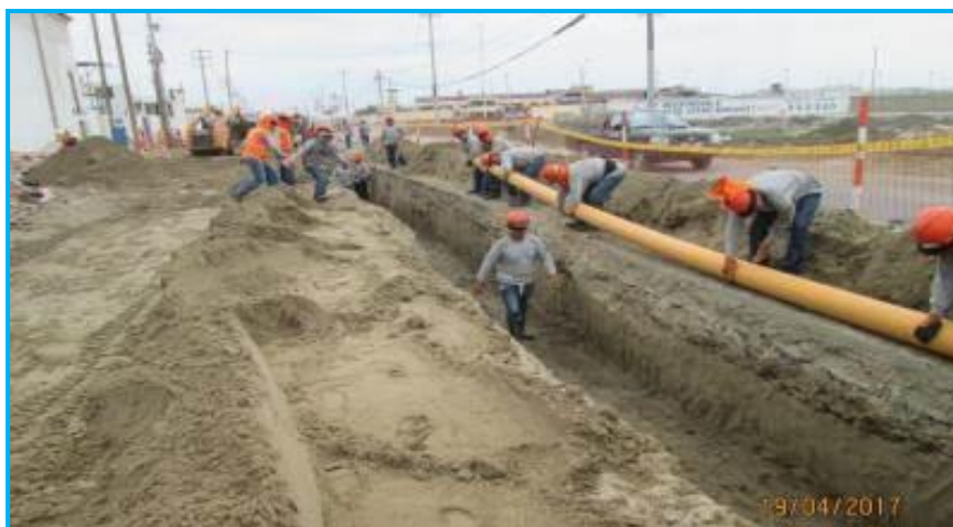
Foto 11.- Vista de maniobras para la bajada a zanja de tubería PE Ø200mm.
