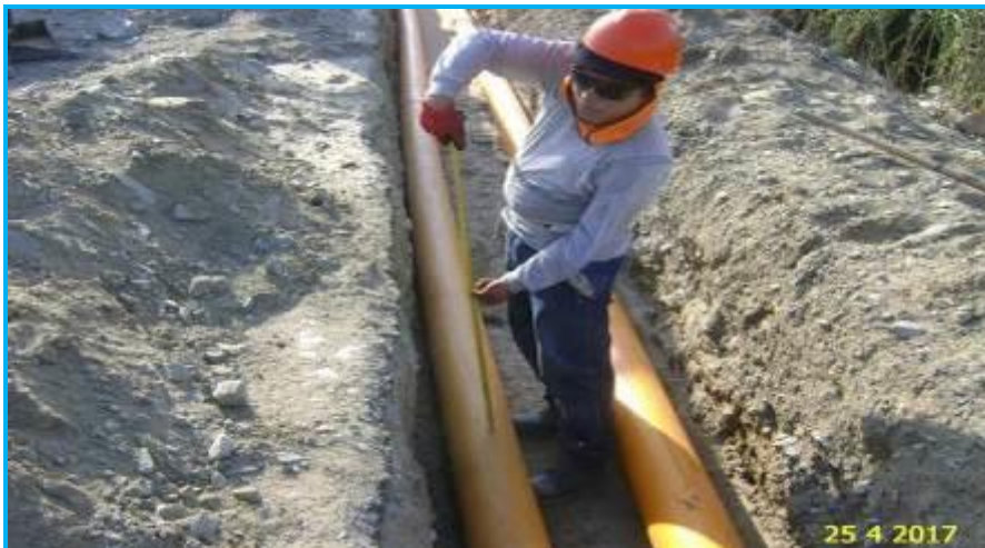
Foto 10.- Redes Chimbote: Verificación de medidas de seguridad entre líneas PE Ø200mm y profundidad de zanja en Av. José Pardo, Proyecto: PE-16-014.
