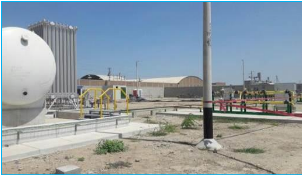
Foto 03.- Vista de Estación de Distrito de Lambayeque
