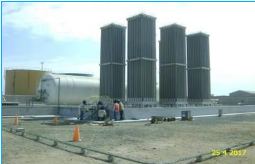
Foto 05.- Vista Estación de Distrito de Chimbote.
