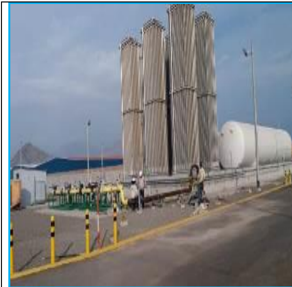
Foto 18.- Trujillo, vista de la instalación de bandejas porta cable eléctricos en área de la ERM.
