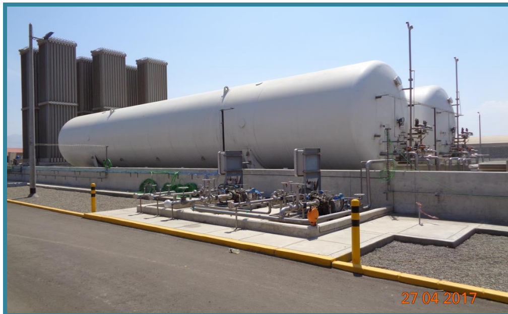
Foto 01.- Vista de la Estación Distrito de Trujillo , zona de bombas de recepción y descarga de GNL.
