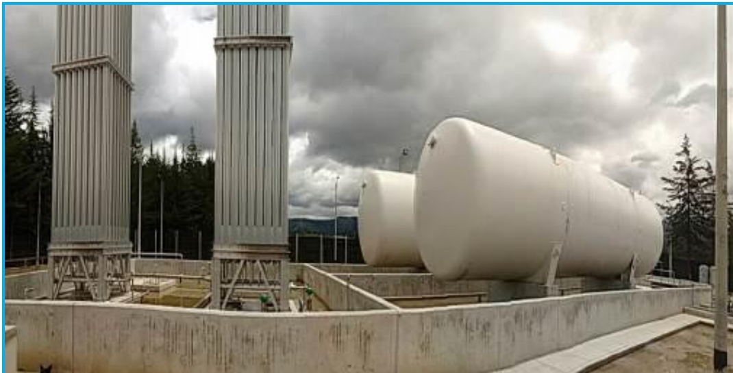
Foto 07.- Vista panorámica de zona de procesos E.D. Cajamarca.
