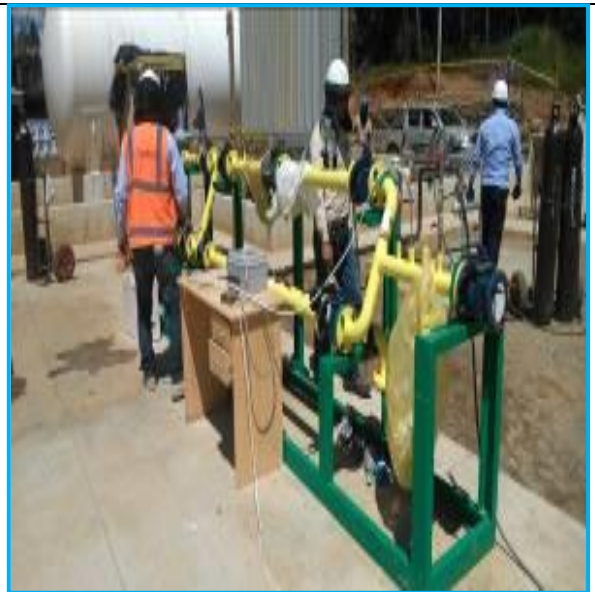
Foto 19.- Vista de la prueba neumática al piping de la ERM de la E.D. de Huaraz.
