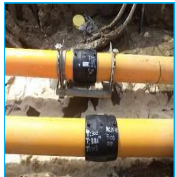
Foto 21.- Redes Chimbote, inspección visual de unión por electrofusión, Ø200mm, en Av. Los Pescadores.
