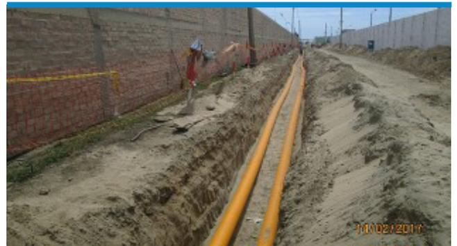
**Redes de Chimbote:** Tendido de tubería de  $\varnothing 200\text{mm}$  en Jr. Santo Toribio.
