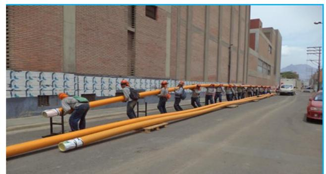
**Redes de Trujillo:** Vista del traslado de tubos de HDPE de  $\varnothing 200\text{mm}$  en la Calle Mantaro.
