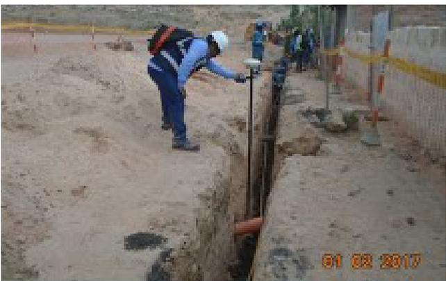
Redes Arequipa: Verificación de ubicación de tubería con equipo GPS.
