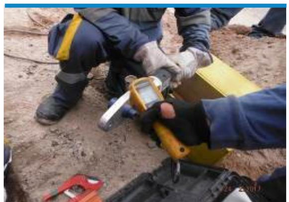
Redes en Arequipa: Verificación de temperatura en unión de tubería de Ø25mm. por termofusión.
