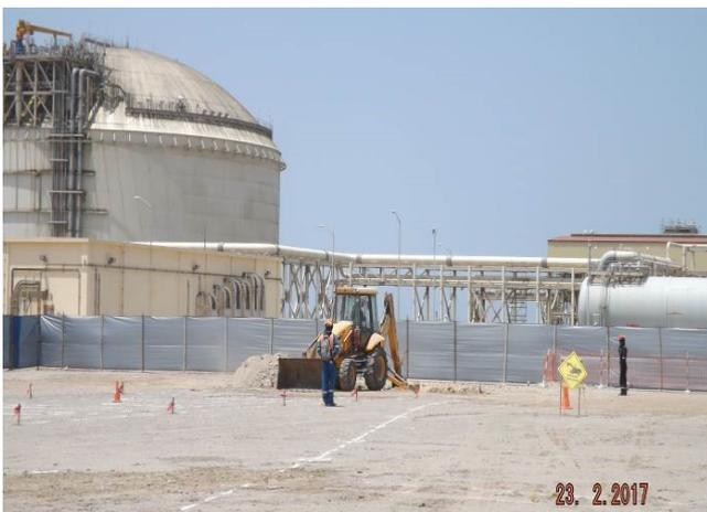
Vista de excavación para cimentación de soportería de tubería de GNL (pipe rack).
