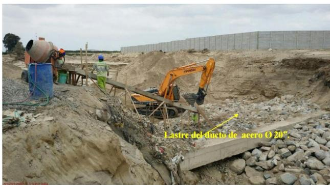
Trabajo de enrocado a los costados del lastre que contiene tubería de acero de 20", Cruce Río Seco.
