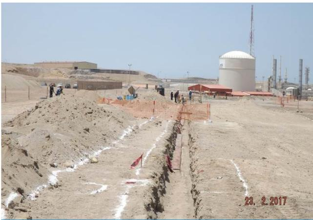
Vista de los trabajos de instalación de mallas de puesta a tierra.
