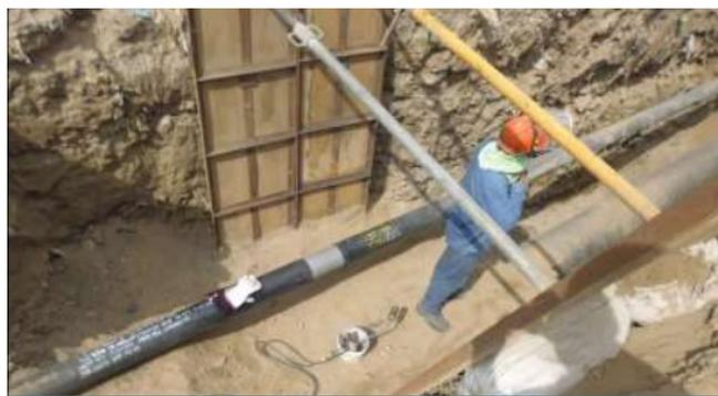
Soldadura en tubería de 6", granallada, previo a la aplicación de la manta termocontraíble, proyecto Ext. de red a los Ferrolles, distrito y provincia del Callao.
