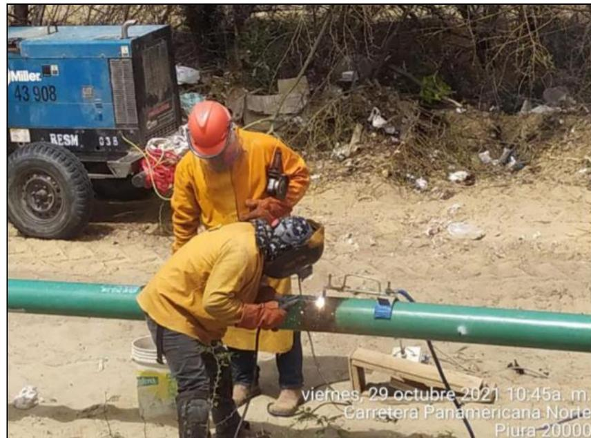
**Foto:** Se aprecia el proceso de soldadura de tubería de  $\varnothing 6''$ , corresponde a la construcción del tramo 6 del gasoducto.
