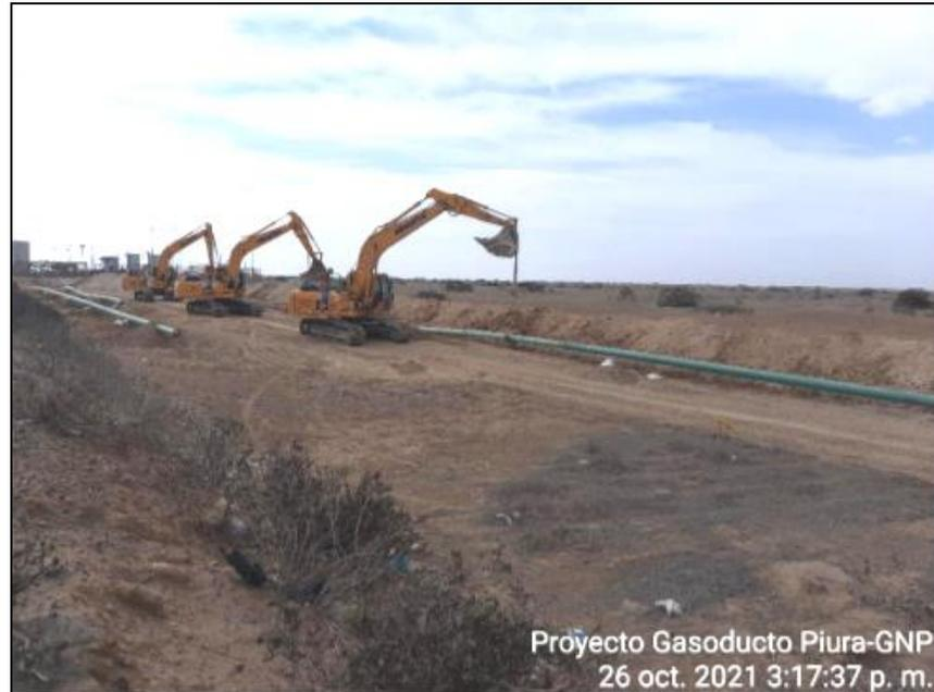
**Foto:** Se aprecia la bajada de tubería de  $\varnothing 10''$  sobre el fondo de zanja, corresponde al tramo 4 del gasoducto.
