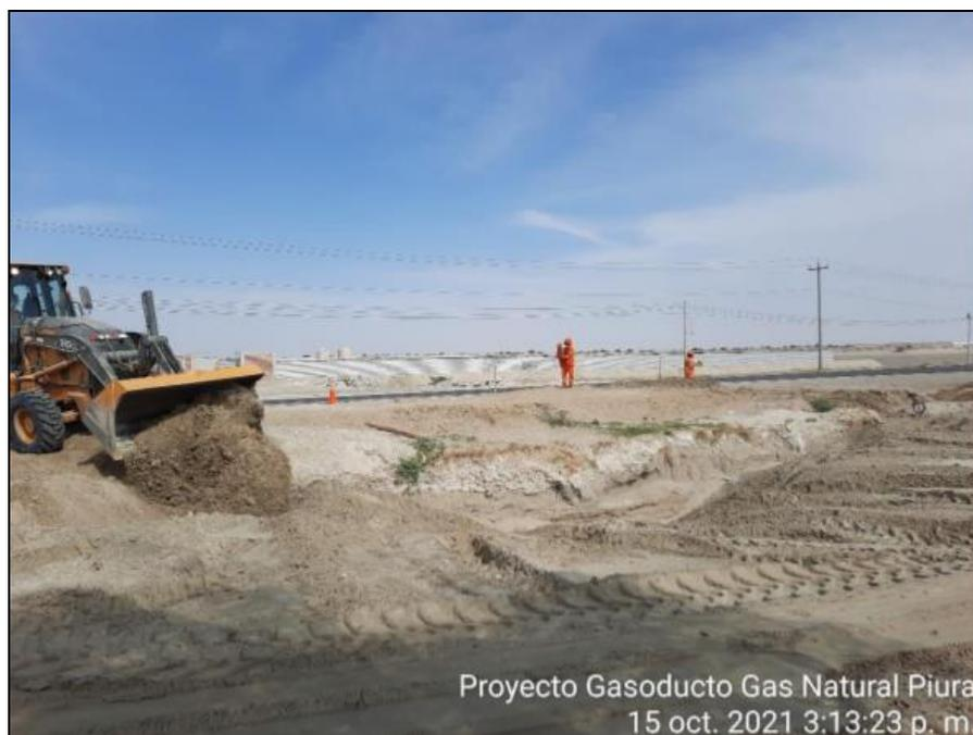
**Foto:** Trabajos de tapada de tubería mediante cargador frontal. Corresponde al tramo 12 del gasoducto.
