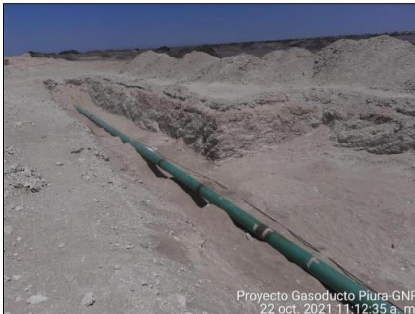
**Foto:** Se aprecia la unión soldada, para el empalme de dos tramos de tubería. Corresponde al tramo 11 del gasoducto.
