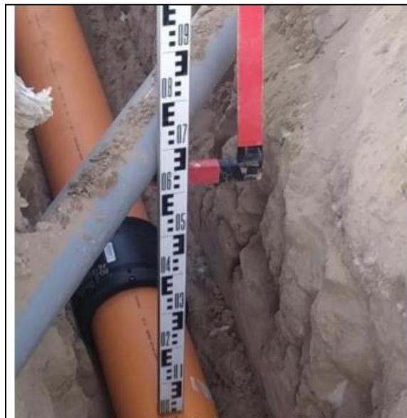
**Foto:** Se verifica la distancia de separación entre tubería de gas con tubería de otro servicio
