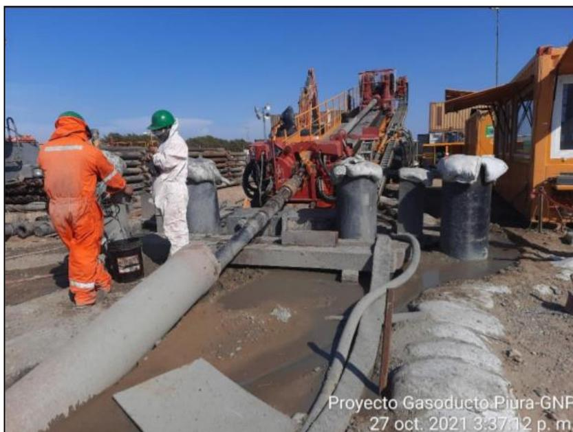
**Foto:** Se aprecia el proceso de Perforación Horizontal Dirigida (PHD) del Cruce Rio Chira – Tramo 03 del gasoducto
