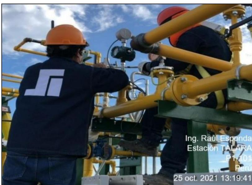
**Foto:** Se observa los trabajos de mantenimiento de instrumentos en el Skid de regulación y medición de gas.
