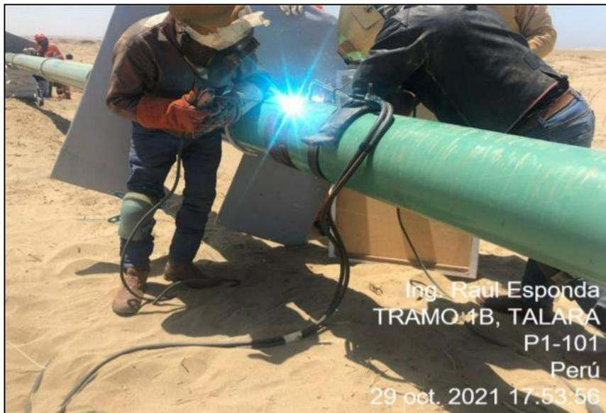
**Foto:** Proceso de soldadura de tubería de  $\varnothing 10''$  correspondiente al tramo 1B del gasoducto.
