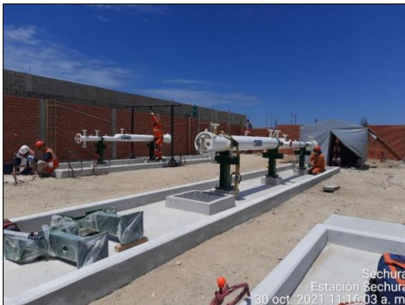
**Foto:** Se observa los trabajos de construcción de base de skid's y muro perimetral de la estación
