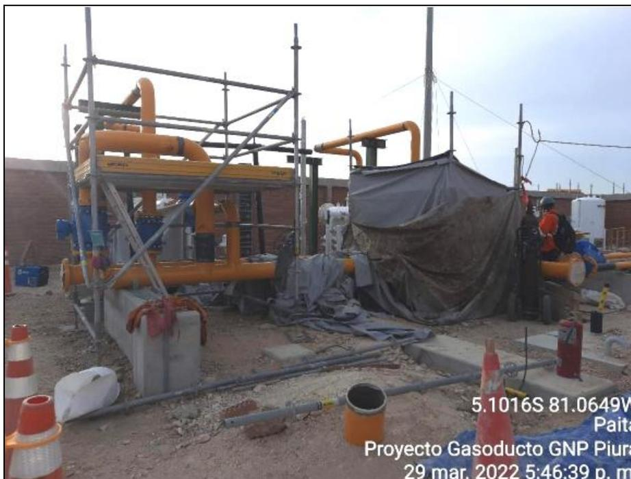
Foto: Se aprecia los trabajos de soldadura de tuberías de acero, para la construcción de prefabricados que conectarán el separador gas.
