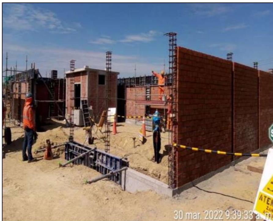
**Foto:** Se aprecia la construcción del recinto que albergará la válvula de seccionamiento ESDV-612 a instalarse en el tramo 6 del gasoducto.
