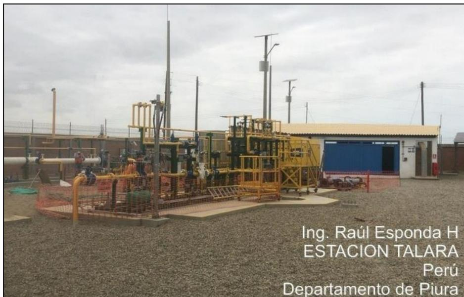
**Foto:** Se observa los trabajos de mantenimiento de skid de filtración y regulación
