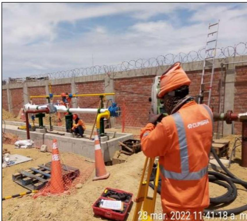
Foto: Se observa el montaje de la trampa receptora de pig - Estación de Sullana
