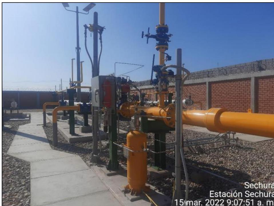
**Foto:** Se observa la trampa receptora de pig y el skid de regulación y medición de gas.
