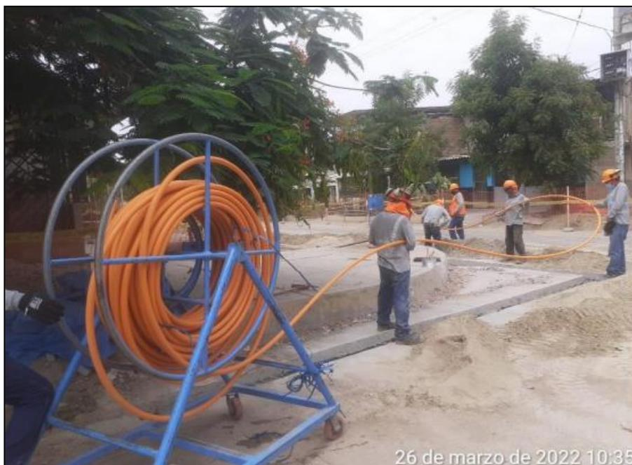
Foto: Se aprecia los trabajos de instalación de tubería de polietileno de Ø32mm en el distrito Veintiséis de Octubre.
