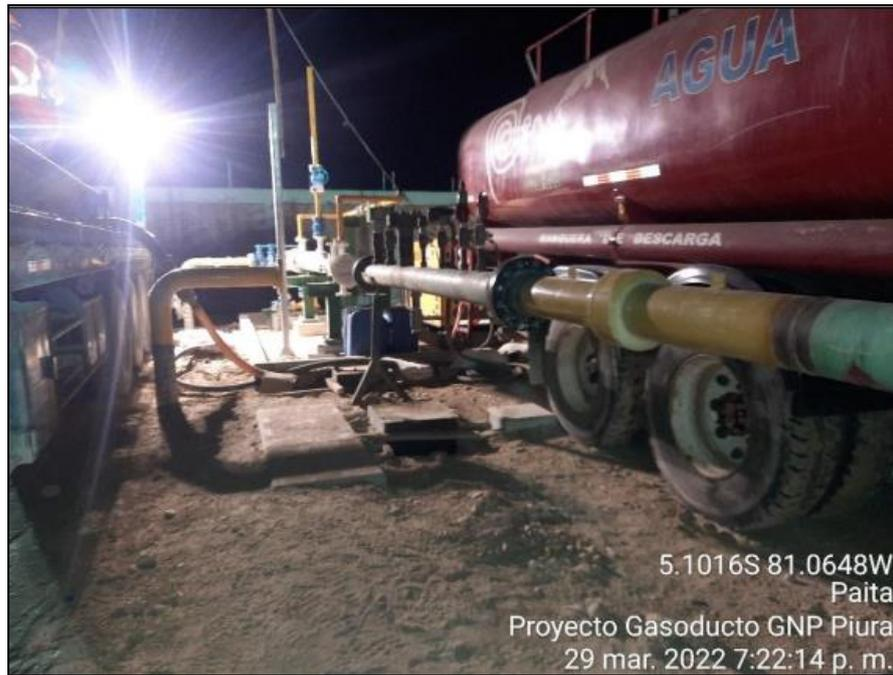
**Foto:** Se aprecia los trabajos preliminares antes inicio de la prueba hidrostática del tramo 4 del gasoducto.
