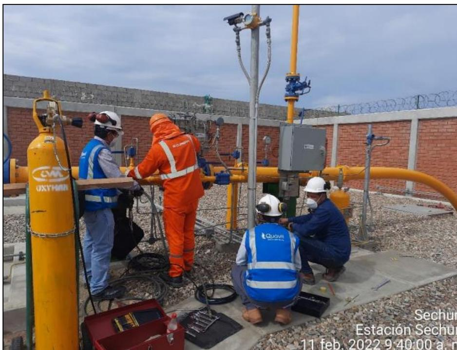
**Foto:** Se observa los trabajos de las pruebas de instrumentos del skid de trampa de recepción.
