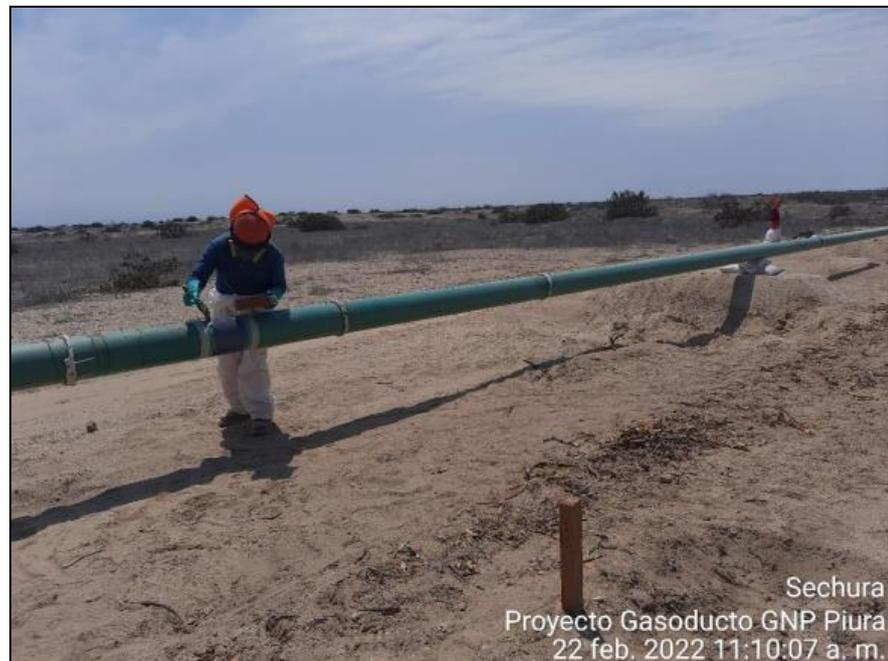
**Foto:** Se aprecia el proceso de recubrimiento en juntas soldadas Tramo 11 del gasoducto.
