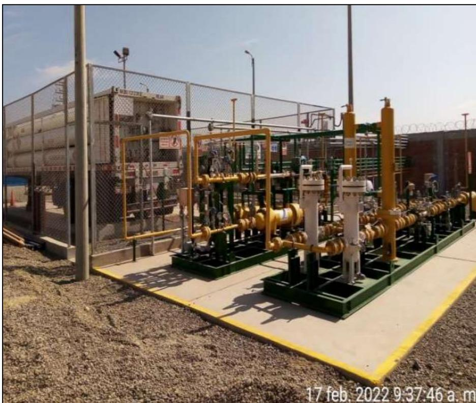
**Foto:** Se observa la zona del skid de regulación y medición de gas - Estación de Sullana
