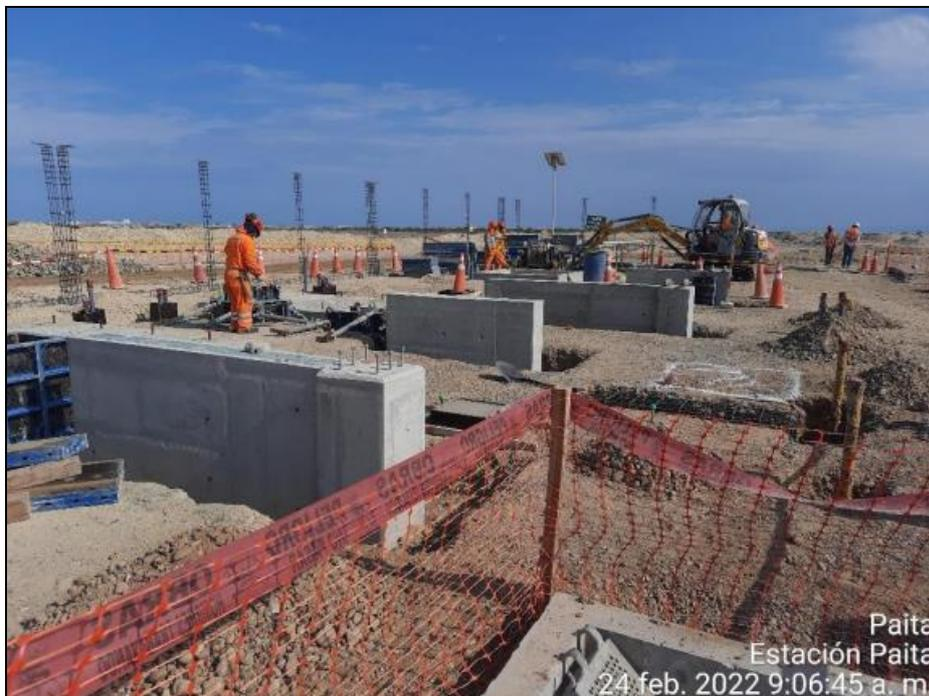
**Foto:** Se aprecia los trabajos de construcción de soportes de tuberías en zona separadores Gas
