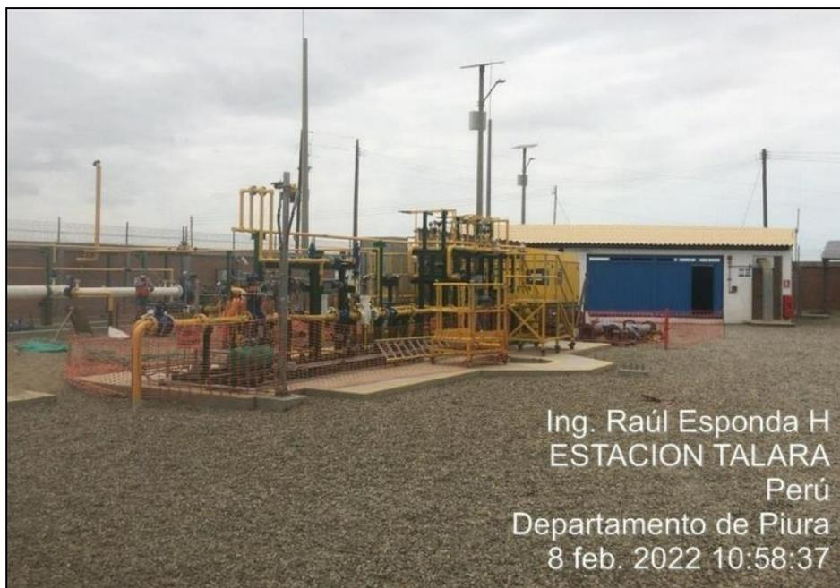
**Foto:** Se observa los trabajos de mantenimiento de skid de filtración y regulación
