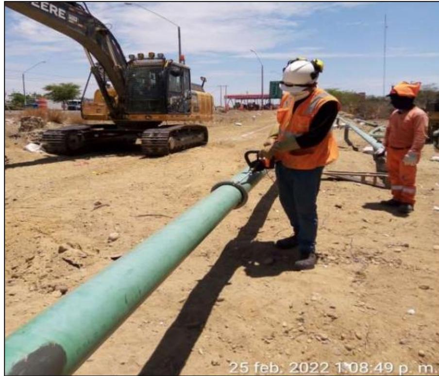
**Foto:** Se aprecia el proceso de verificación de revestimiento mediante equipo holiday test.
