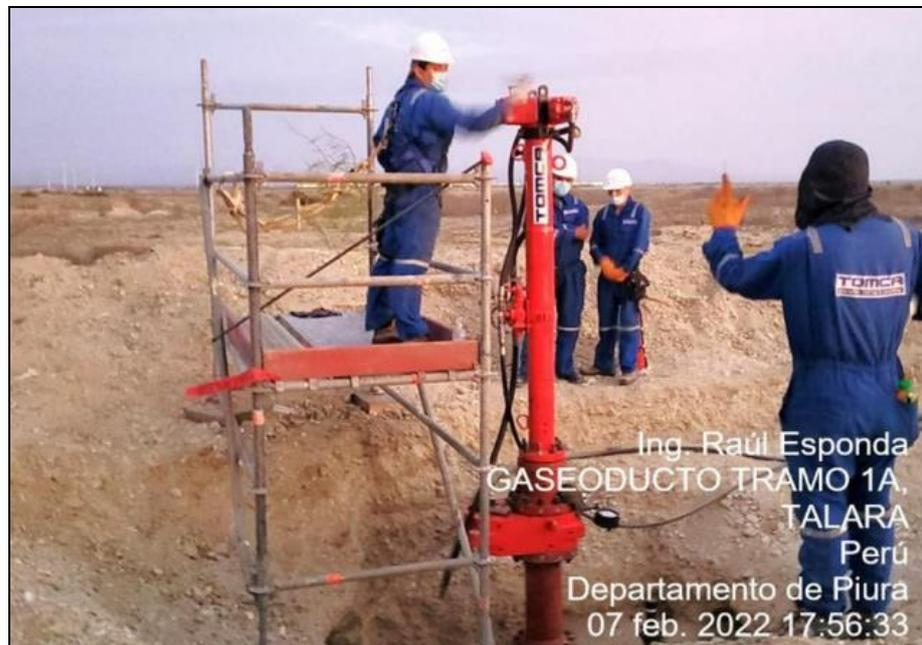
**Foto:** Se verificó el proceso de instalación de válvulas obturadoras en tramo 1A.
