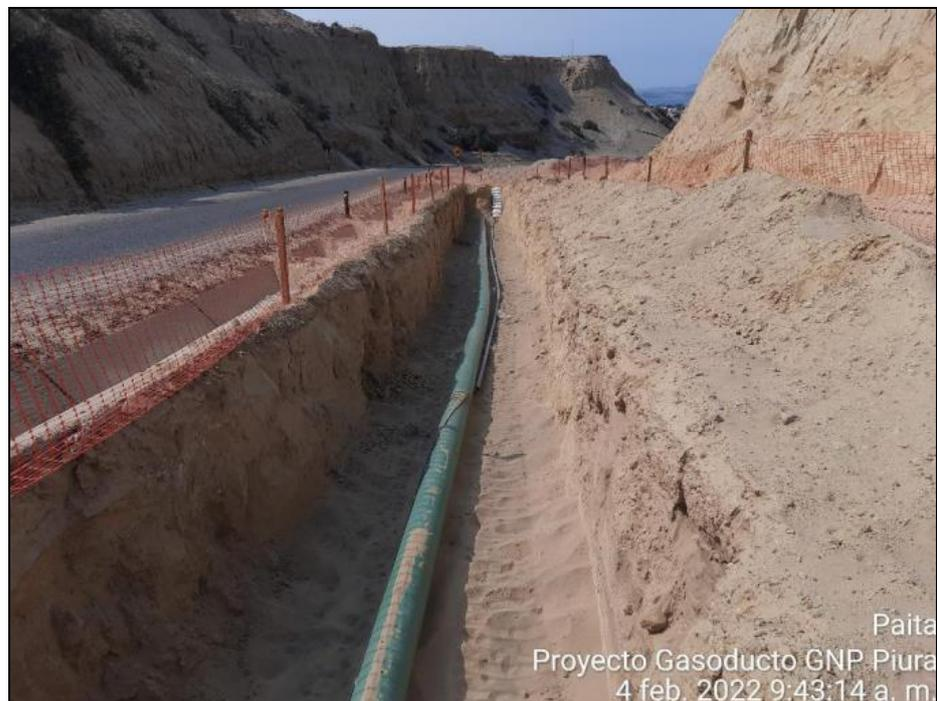
**Foto:** Se aprecia los trabajos de instalación de tubería en zona ref. Pk14 Tramo 04 de gasoducto.
