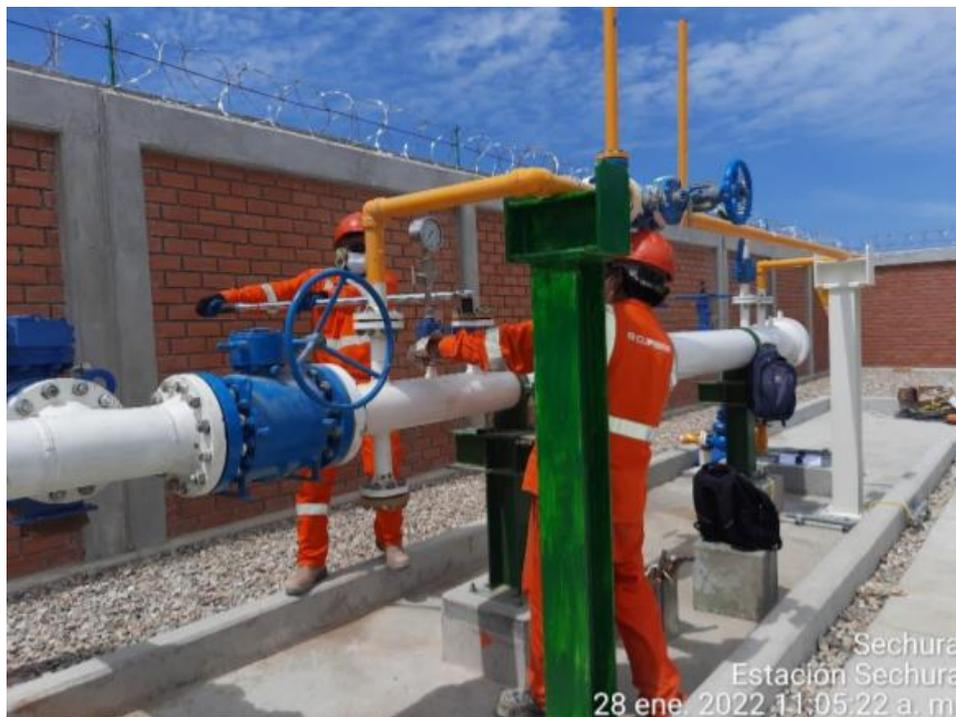
**Foto:** Se observa los trabajos de ajustes de uniones bridadas en el skid de trampa de recepción.
