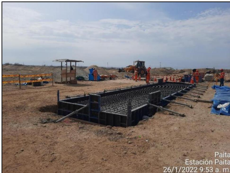
**Foto:** Se aprecia los trabajos de armado de malla de acero para las bases de concreto de skid's.
