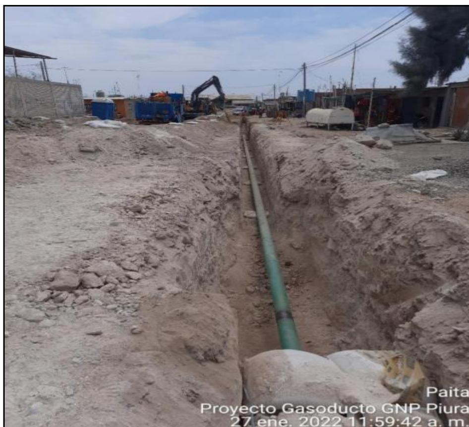
**Foto:** Se aprecia la bajada de tubería de Ø6" sobre zanja. Corresponde al Tramo 09 del gasoducto.
