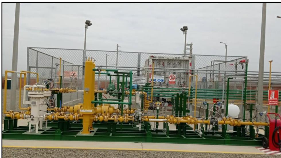
**Foto:** Se observa la zona del skid de regulación y medición de gas - Estación de Sullana
