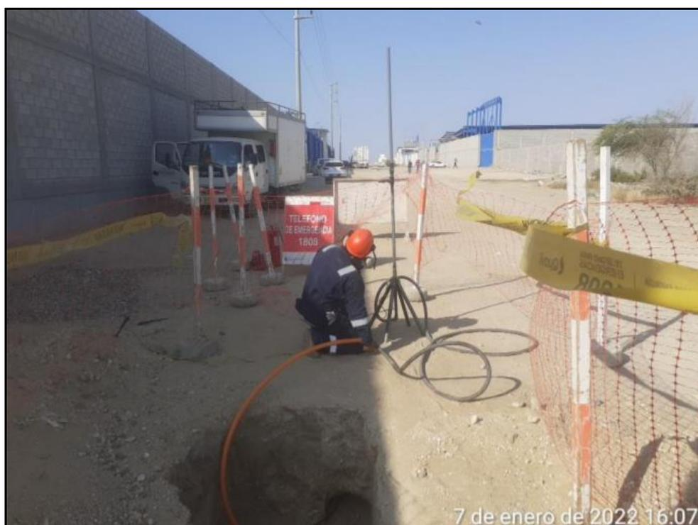
**Foto:** Preparación de tubería de ventilación del gas, previo al gasificado de redes.
