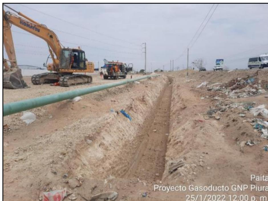
**Foto:** Se aprecia los trabajos de excavación de terreno para la instalación de tuberías Ø10", corresponde a la construcción del tramo 4 del gasoducto.
