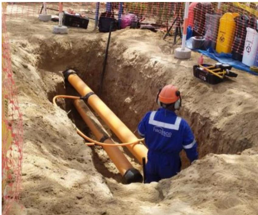
**Foto:** Se verifica los trabajos realizados de empalme de tubería de polietileno de  $\varnothing 110$  mm.
