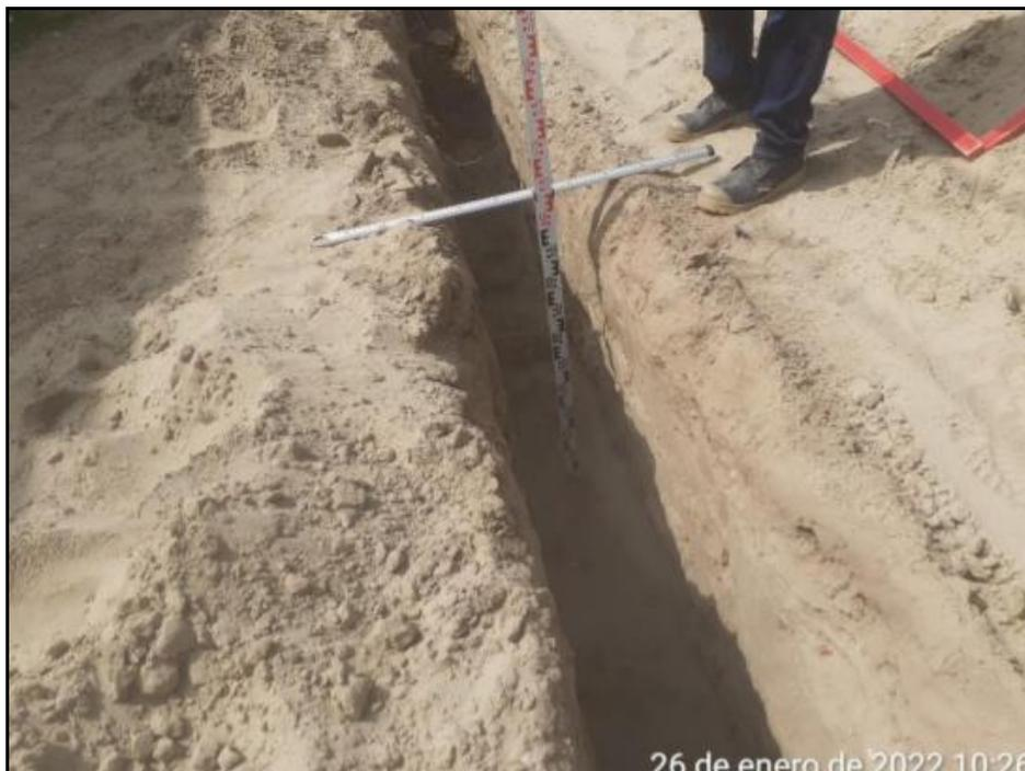
Foto: Se verificó la profundidad de tapada de tubería, no menor de 61 cm.
