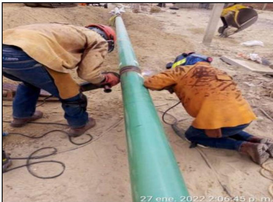
**Foto:** Se aprecia el proceso de soldadura de tubería de Ø6", corresponde a la construcción del tramo 6 del gasoducto.
