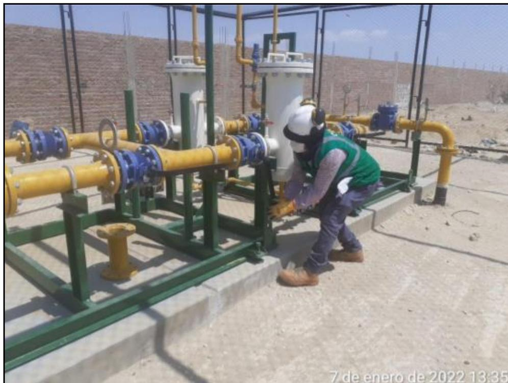
**Foto:** Apertura de la válvula de la ERMP para el ingreso de gas donde se recibirá el gas proveniente de la empresa Olympic.
