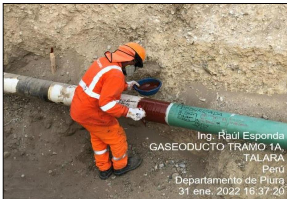
**Foto:** Se verificó la aplicación de recubrimiento a junta de cierre y empalme en tramo 1A.
