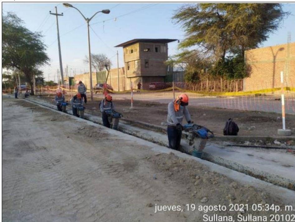
**Foto:** Se observa los trabajos de compactación de terreno, luego de realizado la instalación de tubería de polietileno
