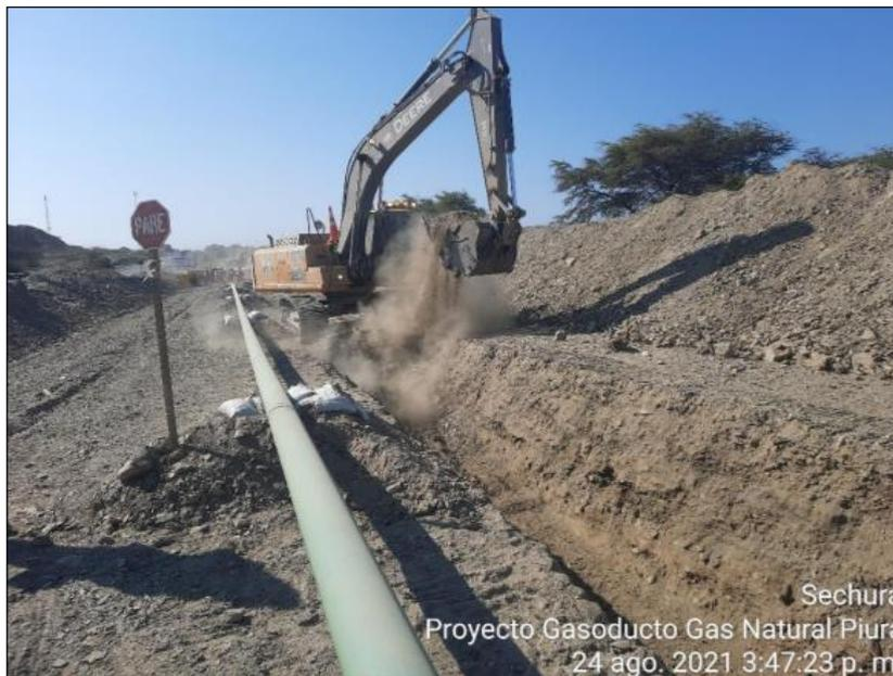
**Foto:** Excavación de terreno para bajada de tubería.
