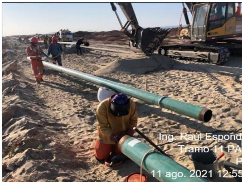
**Foto:** Preparación de tubería previo a la soldadura.
