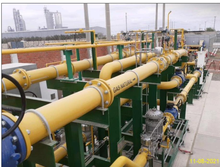
**Foto:** Se observa los skid de regulación y medición de la estación de Piura
