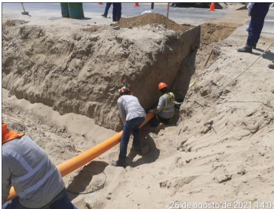
**Foto:** Instalación de tubería de polietileno de Ø200mm
