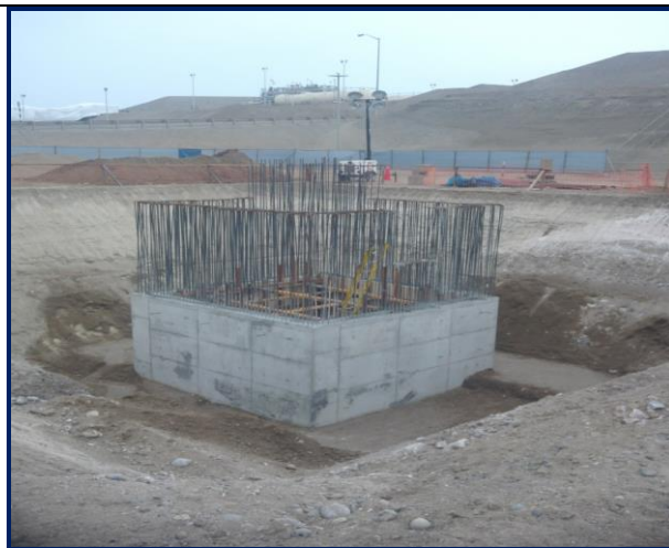
Foto 3. Vista de la construcción de poza de derrame
