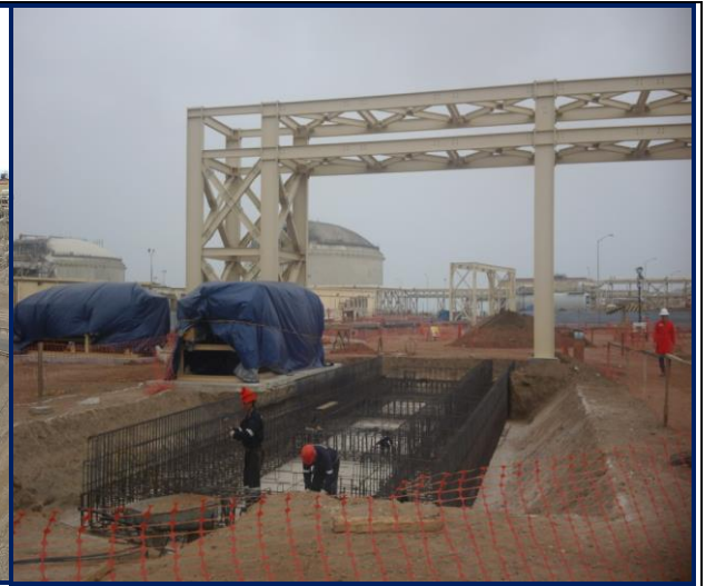
Foto 2. Vista de la construcción de la cimentación de balanza de carga
