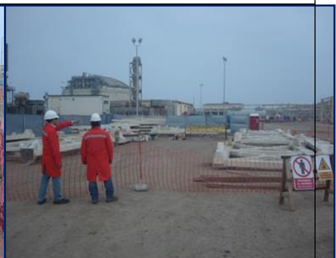
Foto 6. Vista de las partes del puente N° 1, para su armado
