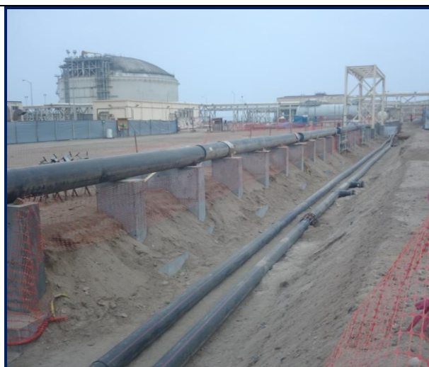
Foto 5. Vista de las tuberías contraincendios
