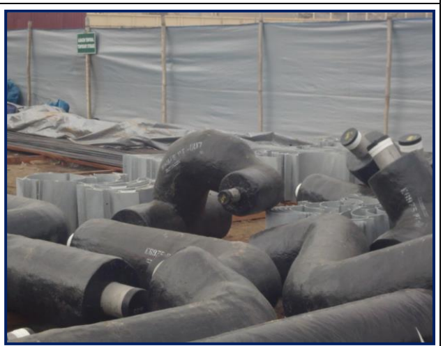
Foto 4. Vista de los tramos curvos de tubería
