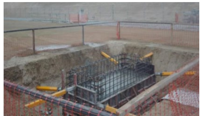
Vista de la construcción de la cimentación de balanza de carga.
