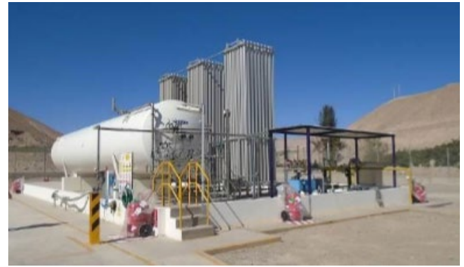
Vista de la Estación de Distrito Moquegua.
