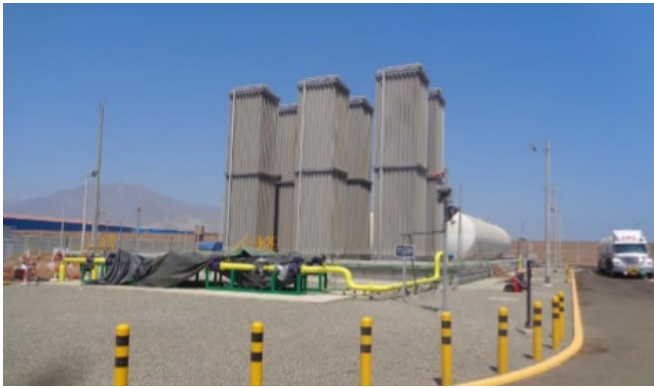
Vista de la Estación de Distrito de Trujillo.
