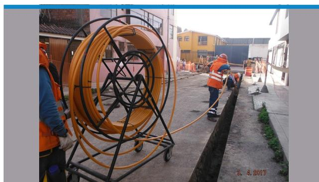
**Redes Arequipa:** Verificación de instalación de tubería de 25 mm sobre cama de arena.
