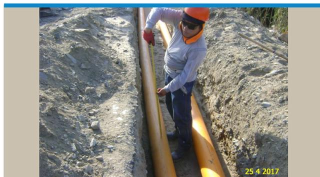
**Redes de Chimbote:** Verificación de medidas de seguridad en la instalación de tubería de PE Ø200mm en la Av. José Pardo.
