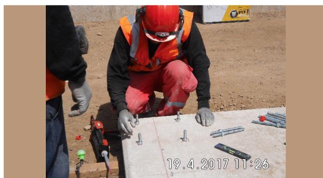
Colocación de pernos de anclaje para los equipos a instalarse en el City Gate Cañete, distrito de San Vicente de Cañete y provincia de Cañete.
