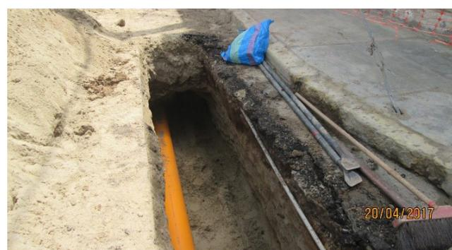
**Redes de Trujillo:** Vista de la instalación de tubería de PE Ø200 mm en Psje. Martínez Pinilla con calle Santa.
