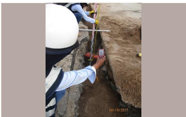
**Redes Tacna:** Verificación de distancia mínima a interferencia y tapada de tubería de  $\varnothing 32$  mm.
