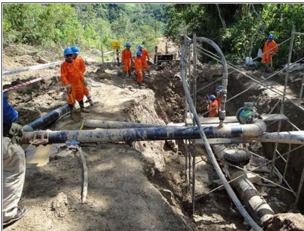
FOTO N° 02: Desacople de un extremo del bypass de aproximadamente 80 m finalizada la reparación de la línea. Dicho bypass permitió seguir operando el ducto de transporte de LGN mientras se ubicaba y reparaba la falla.
