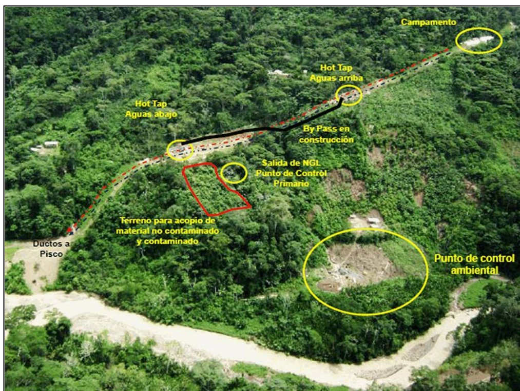
FOTO N° 01: Vista panorámica de la zona donde se detectó incidente de falla en el ducto de transporte de líquidos de gas natural.
