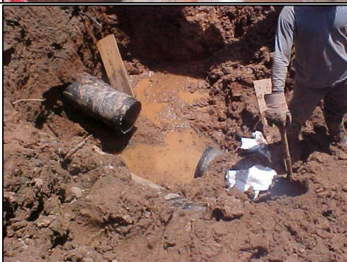
Imagen 07, 08 y 09: Trabajos de reparación del ducto fallado.
