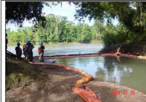
Imagen 02: Quebrada de Kemariato. Nótese las barreras de contención y absorbentes.
