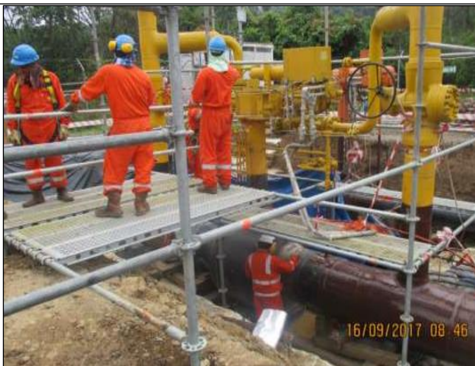
Figura 03: KP 179+412, inspección de los trabajos de reparación de la fisura detectada.
