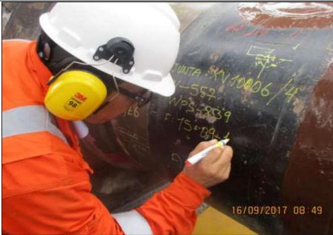
Figura 04: KP 179+412, inspección de los trabajos de reparación de la fisura detectada.
