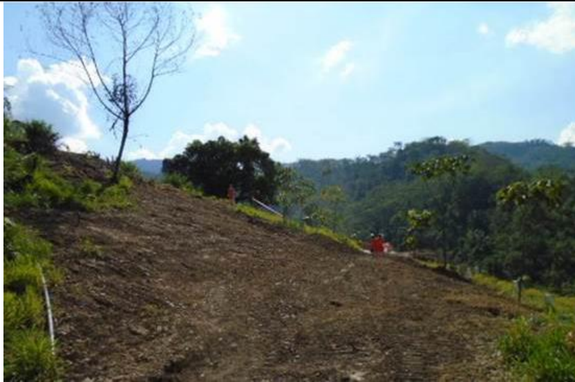
Figura 04: KP 181+800 - Trabajos de reconfomación de terreno en el DDV (fuente TGP).
