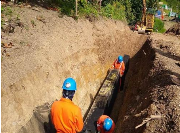
Figura 03: KP 181+800 - Instalación de trinchera drenante y tapado de excavación (fuente TGP).
