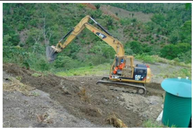
Figura 03: KP 181+800 - Instalación de trinchera drenante y tapado de excavación (fuente TGP).
