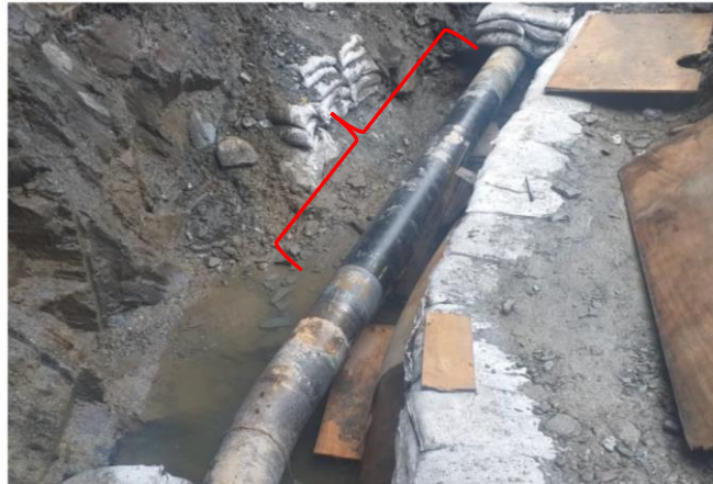
Figura 05: Vista panorámica de la tubería reparada (Fuente: TGP)
