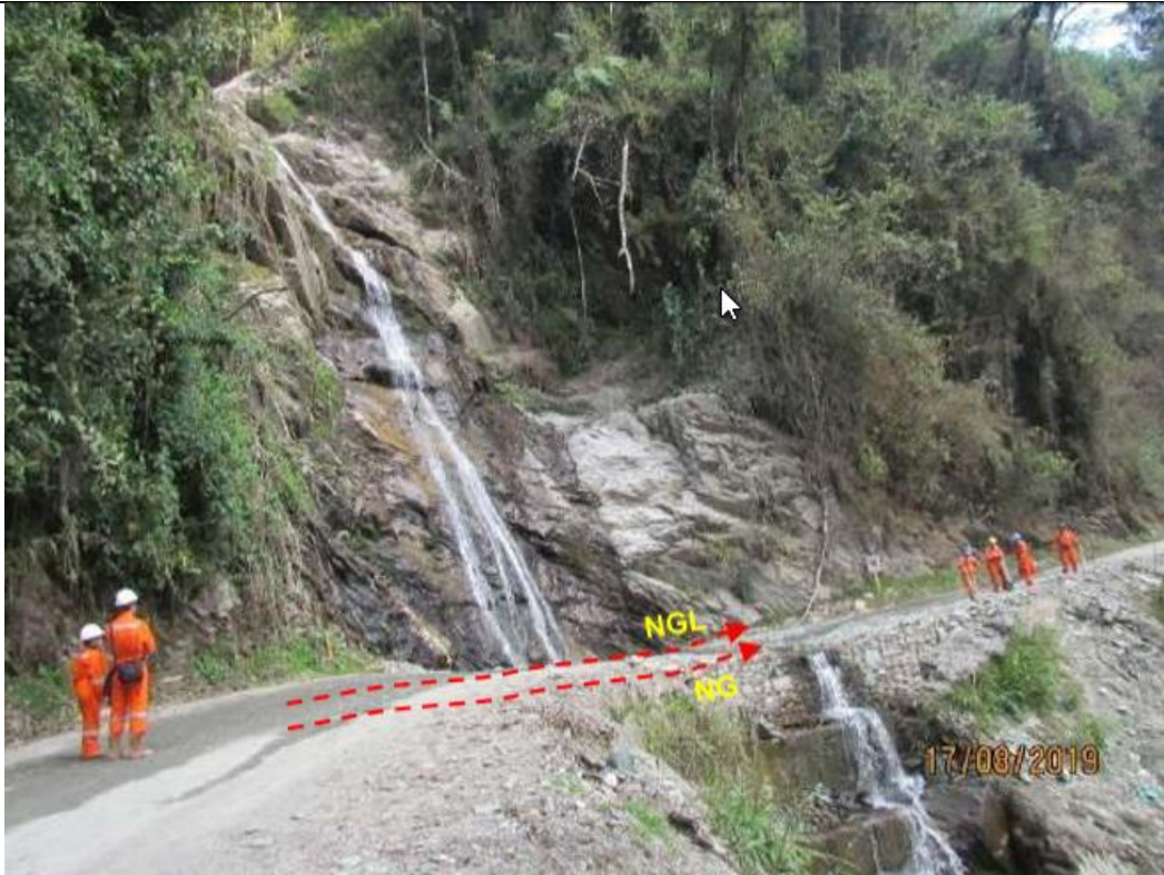
Figura 02: KP 194+989, Vista panorámica del DDV, en cruce con la Quebrada Chaupiorcco, con relevamiento topográfico en proceso, con gaviones de protección en margen derecha. (IS-0001003816-EPC-ARB)
