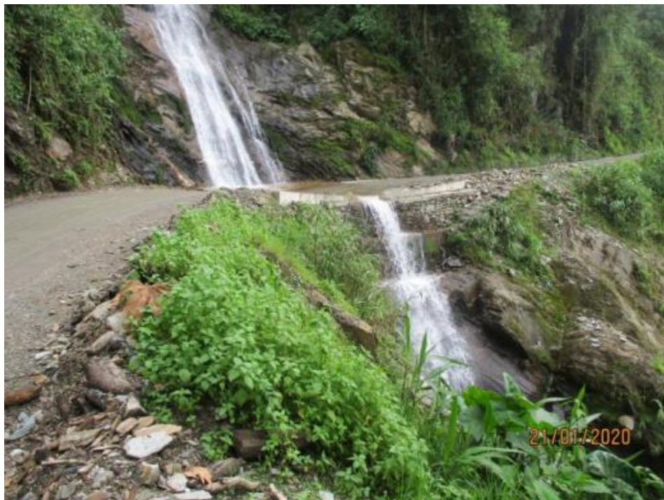
Figura 06: Vista panorámica de la zona KP 194+989. Presenta obras de remediación geotécnica concluidas. Fuente: (Informe de Supervisión IS-0001004271-EPC-JAB)
