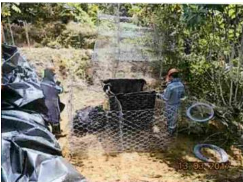
Figura 03: KP 003+400 – Construcción de cajas de gavión para ser instalados y rellenos en la base del talud deslizado. Fuente: Repsol
