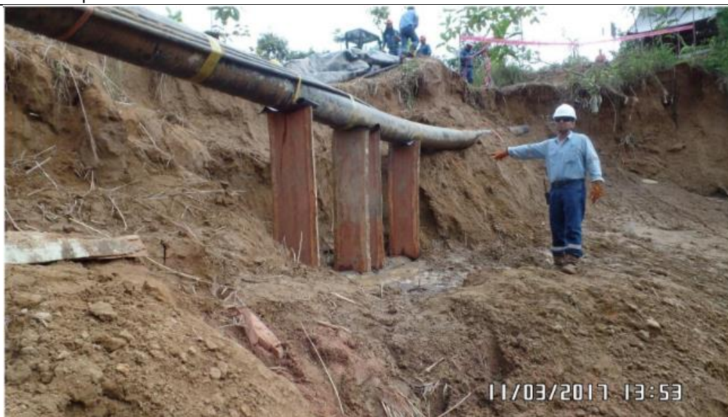
Figura 05: KP 003+400, verificación de los soportes de madera instalados para evitar la suspensión del ducto expuesto.
