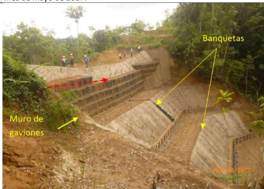
Figura 07: KP 003+400 – Trabajos de estabilización de talud lado derecho del DDV con obras de geotecnia consistente en la construcción de muro de gaviones, talud banquetas, trinchos, acueductos y cajas sedimentadoras, seguimiento realizado por Osinerghmin en el mes de noviembre de 2017.
