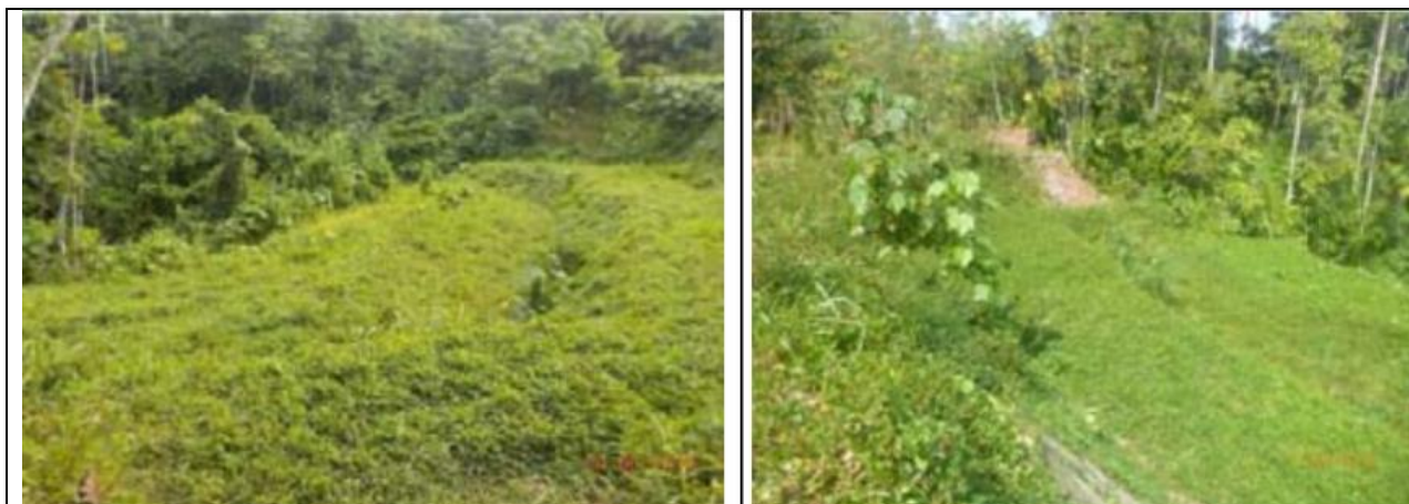
Figura 08: Obras definitivas en el KP 22+100 y revegetación de la zona (Fuente: Reporte de Inspección KP23 a KM14 u600 – julio 2018)
