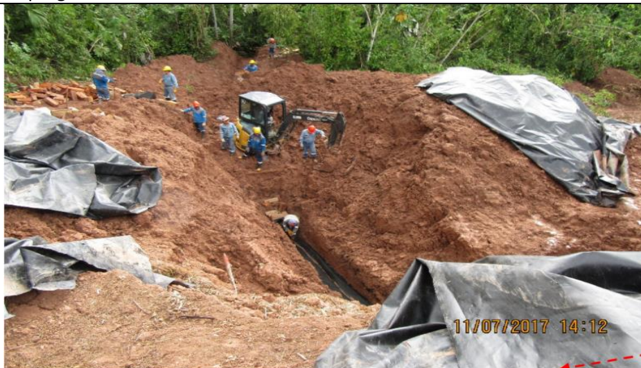
Figura 07: Verificación de obras definitivas de geotecnia consistentes en la construcción de canales de drenaje en la parte inferior del talud.
