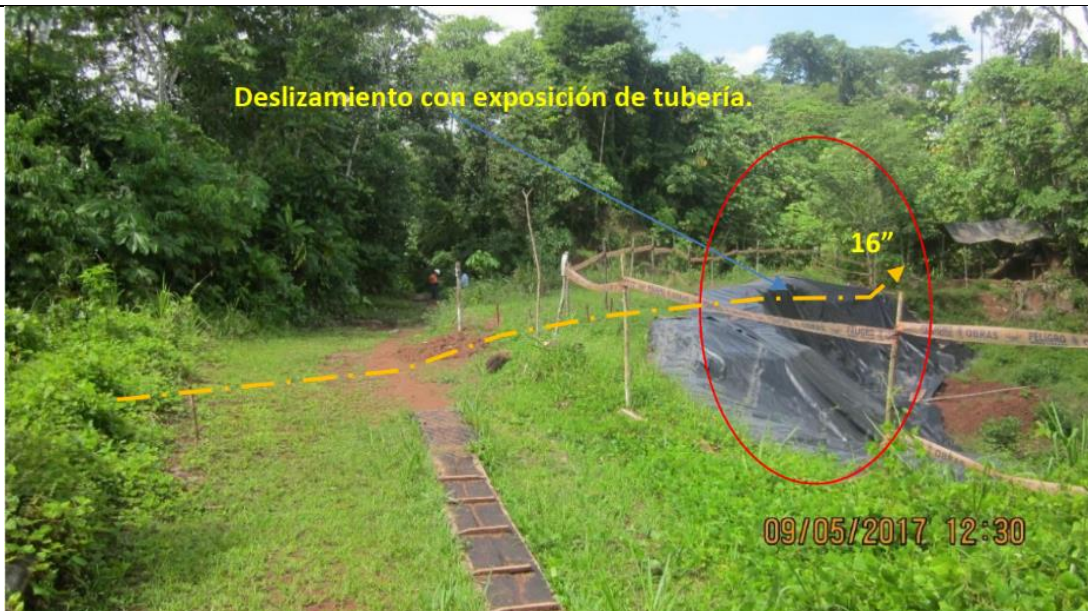
Figura 06: Verificación de obras temporales en el deslizamiento del KP 22+100, el cual se muestra cubierto con geomembrana.
