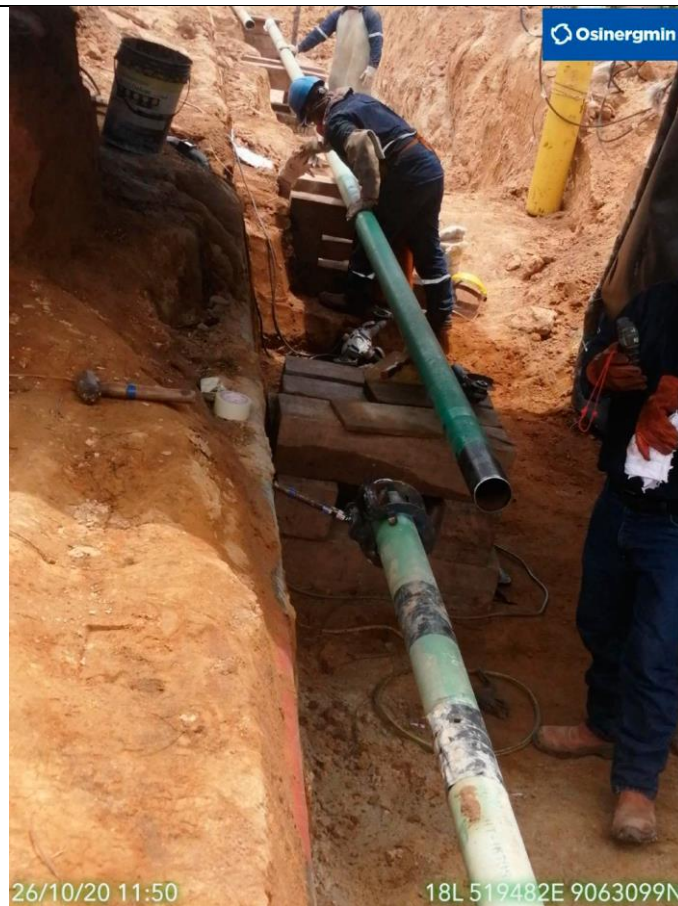
Figura 04: KP 64+000: Vista del niple de reemplazo, durante la ejecución de las actividades de acondicionamiento y alineamiento en zanja.
