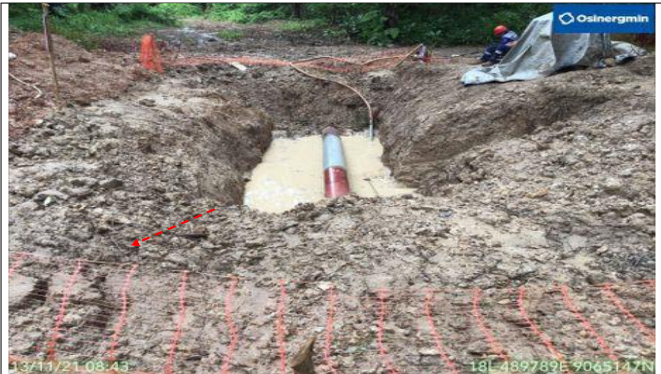
Figura 04: Vista panorámica de la zona de afectación al ducto, KP 16+940 tramo Planta de Gas - Estación Neshuya. Se aprecia el reemplazo del tramo afectado por daño de equipo mecánico. Se abate nivel freático con motobomba.
