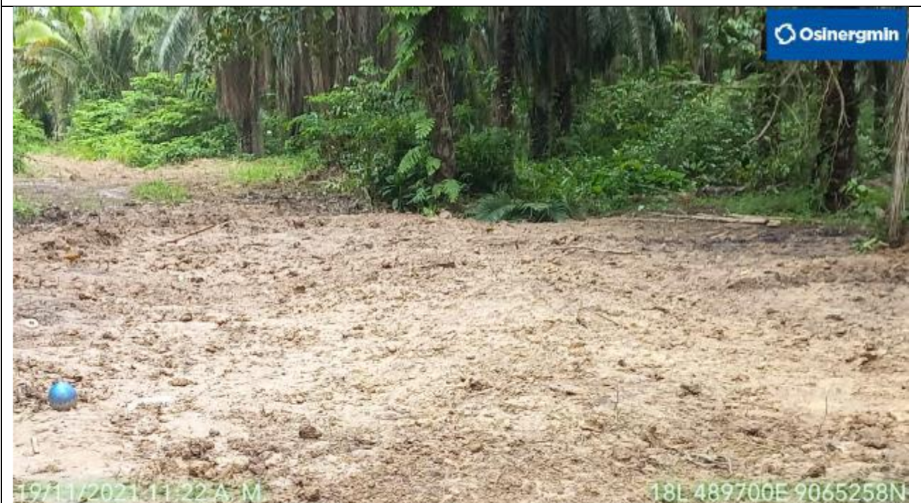
Figura 05: Vista panorámica de la condición de riesgo a la altura del KP 16+940, en la cual se aprecia que los trabajos de reparación ya culminaron y se encuentra tapado.
