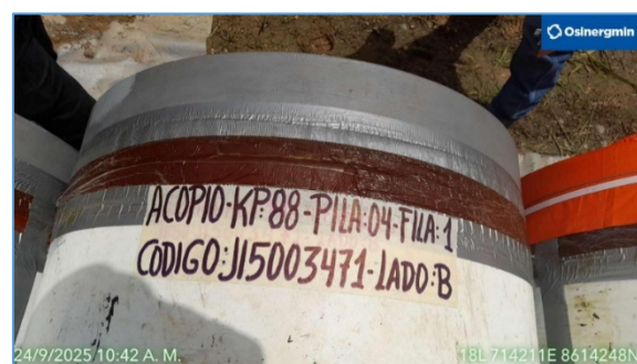
Área 2: Acopio KP 88. Verificación del estado del revestimiento externo de la tubería.
