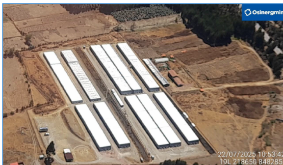
Área 4: Vista aérea de Acopio KP 356 – Urcos. Las pilas de tubos cuentan con cobertura de lona.
