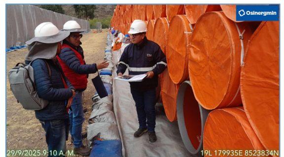
Área 4: Acopio Calca. Vista del personal de la Contraloría y del Administrador inspeccionando la tubería de 32" de la pila 6 de dicho acopio.
