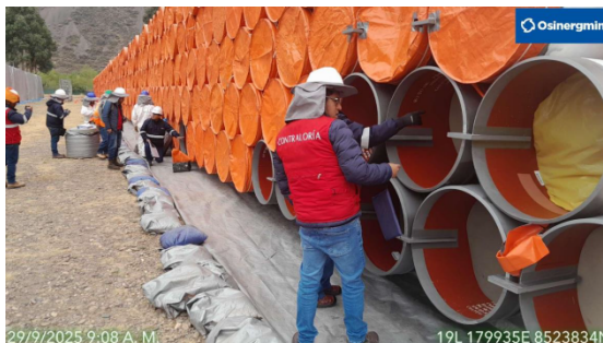
Visita técnica del personal de OCI: Inspeccionando el interior de una tubería de 32" (acopio de Calca).
