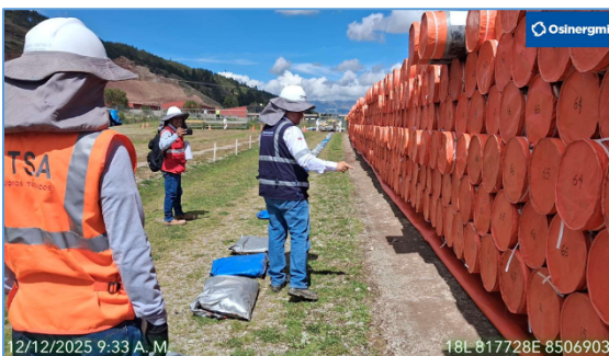
Área 4: Verificación del procedimiento de entrega de los bienes de la concesión en el Acopio de Anta.
