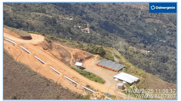
Área 3: Vista área del DDV KP 153+850. Las tuberías desfiladas y soldadas cuentan con cobertura de lona para protección contra los rayos UV.
