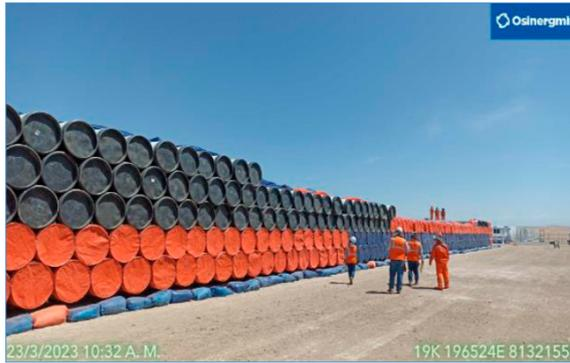
**Área 5:** Acopio KP 777. Supervisión de la preservación de la tubería acopiada.
