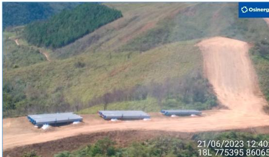
**Área 3:** Tramo de KP 162+700. Vista aérea de la tubería acopiada temporalmente en el DDV, se aprecia las pilas de tubos cubiertos con lona para protección contra los rayos UV.
