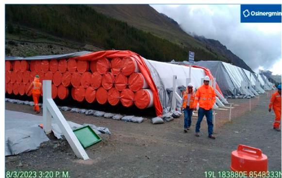
**Área 4:** Acopio KP 276. Supervisión de la preservación de la tubería de la pila 6 del acopio.
