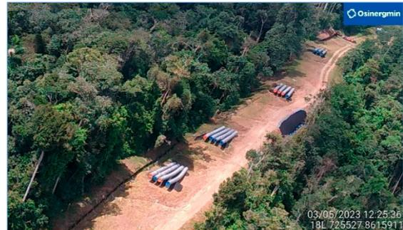
**Área 2:** Vista aérea del DDV. Se aprecia las pilas de tubos cubiertos con lona para protección contra los rayos UV.
