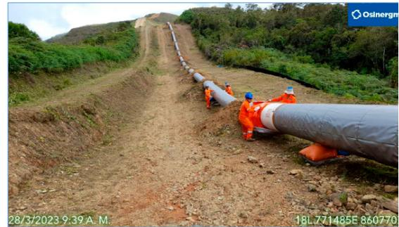
**Área 3:** Tramo del KP 157+500 a KP 158+800. Supervisión de la preservación de la tubería desfilada soldada.
