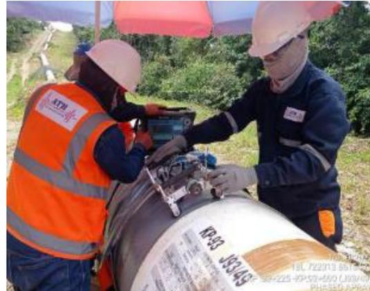
**• Medición de Espesores por Ultrasonido (Scan A)**
