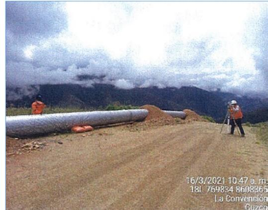
• **Levantamiento y control Topográfico en acopios.**
